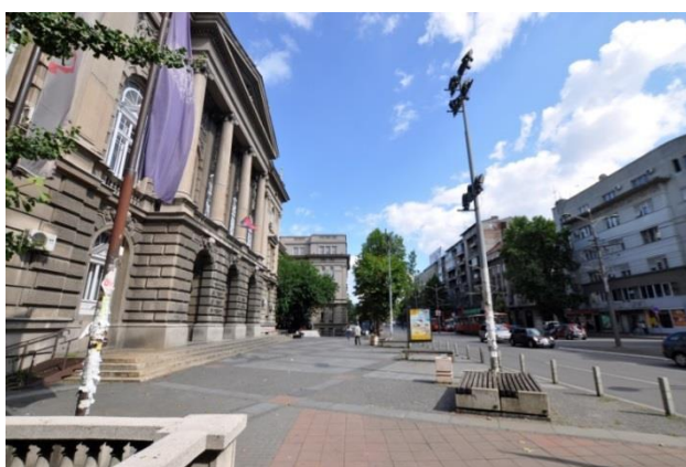
Slika 10.30 Mikrofonski niz na fasadi zgrade (gore) i profil ulice u kojoj je izvršeno merenje (dole)
