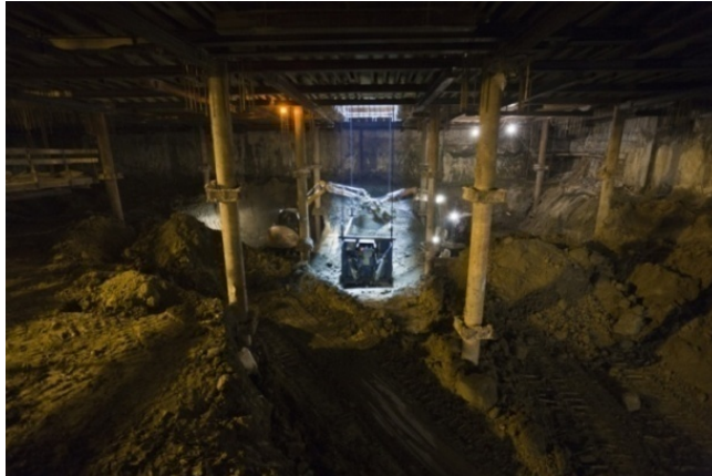
Slika 1.2 CFT stubovi u "top down" metodi gradnje
