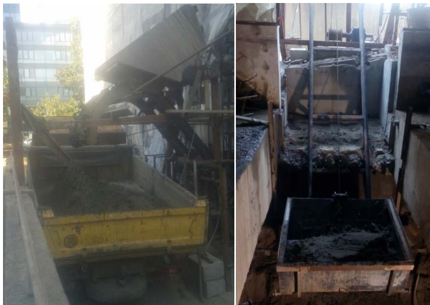
Slika 3.4 Garnitura za vertikalni transport iskopanog materijala
