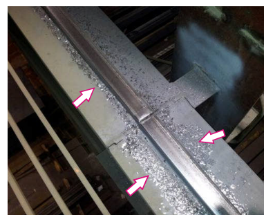
Sl. 1.13 Metalni opiljci pored šine
