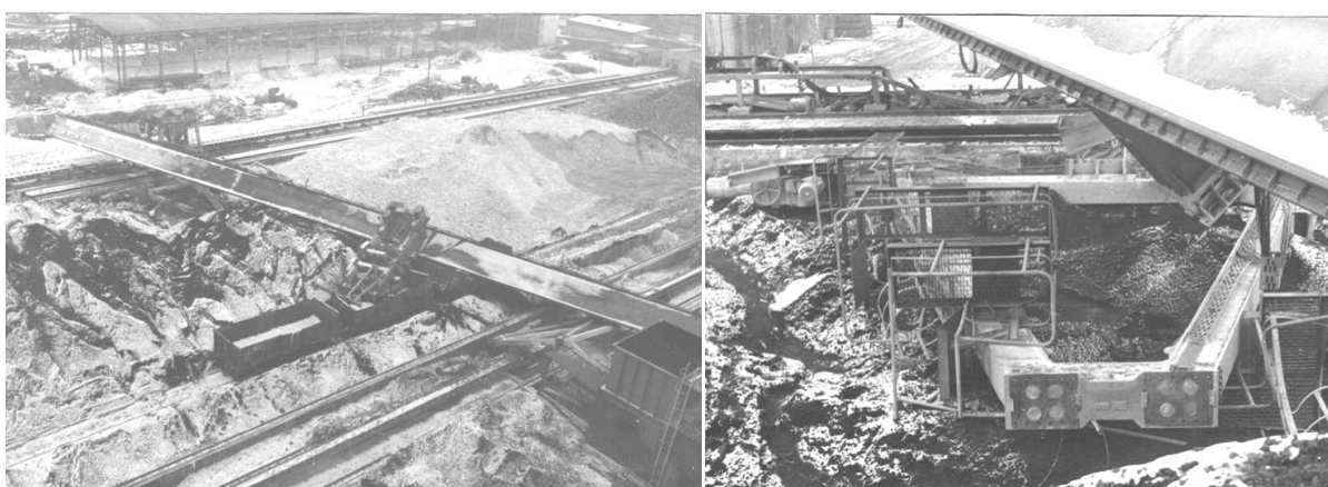
Sl. 1.24 Kolaps portalne mosne dizalice velikog raspona na deponiji, [271]
