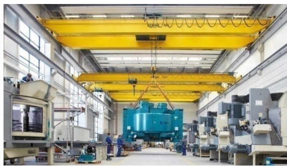
f) mosne dizalice u industrijskoj hali, Demag , Nemačka, [262]
