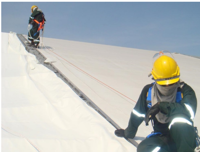
17 – Montaža membrane ( www.temembrane.com )
