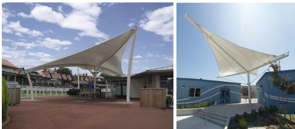
77 – Membranske konstrukcije sa rombičnim osnovama ( www.tensilestructures.net , www.archiexpo.com )
