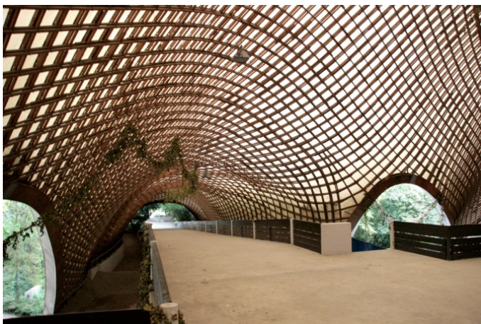
7 – Konstrukcija kod koje je membrana pokrivač ( http://informesdelaconstruccion.revistas.csic.es )
