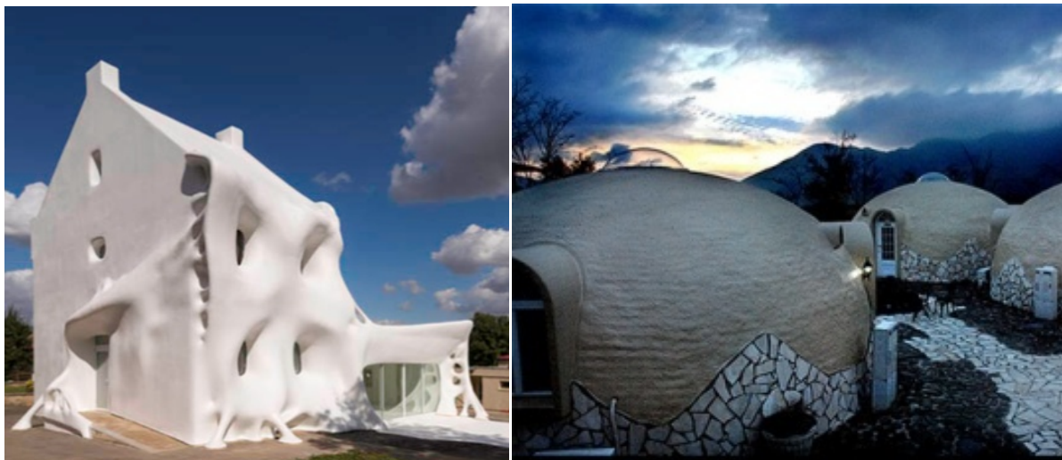
Slika 5 - levo - izgled kuće nakon aplikacije polistirena kao završnog fasadnog sloja (Bedager i Pežu ( Bedaguer i Pejus ), projekat Goust Haus ( Ghost House ), preuzeto februara 2017 sa www.house-crazy.com/ghost-house-for-guests/ ); desno - Generisanje kupolastih struktura u potpunosti izvedenih od polistirena (Doum Haus Internešnal ( Dome House International ) projekat preuzet februara 2017 sa www.usadomes.com/ februara 2017)
