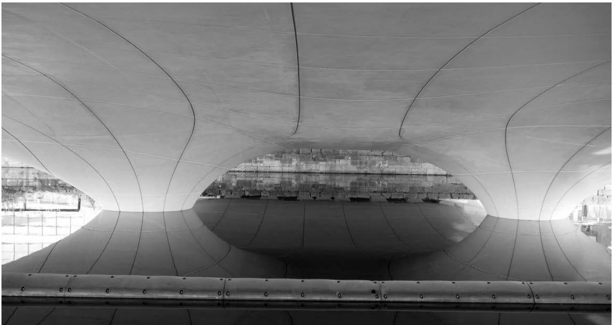
Slika 4 - Prikaz donje strane Spenser Dok Bridž projekta, za koji je korišćen polistiren kao oplata (projektni biro Amanda Levetej Arhitekts ( Amanda Levete Architects ) preuzeto februara 2017 sa www.archdaily.com/96400/spencer-dock-bridge-amanda-levete-architects )
