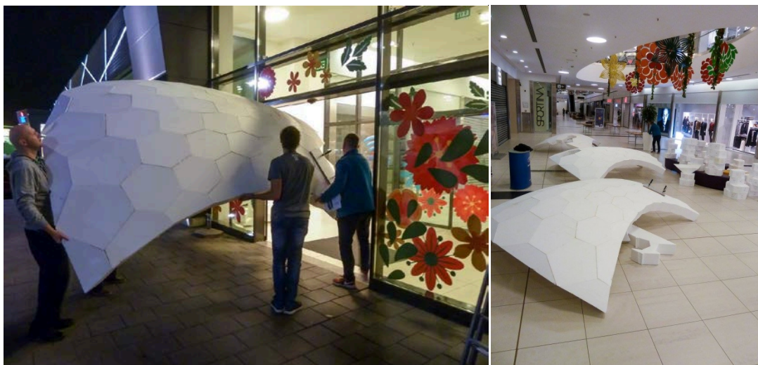
Slika 43 - levo - prikaz veličine završenog kraka, kao i mogućnost manevrisanja prilikom unošenja u prostor postavke; desno - prikaz tri završena kraka i K elemenata na mestu postavke
