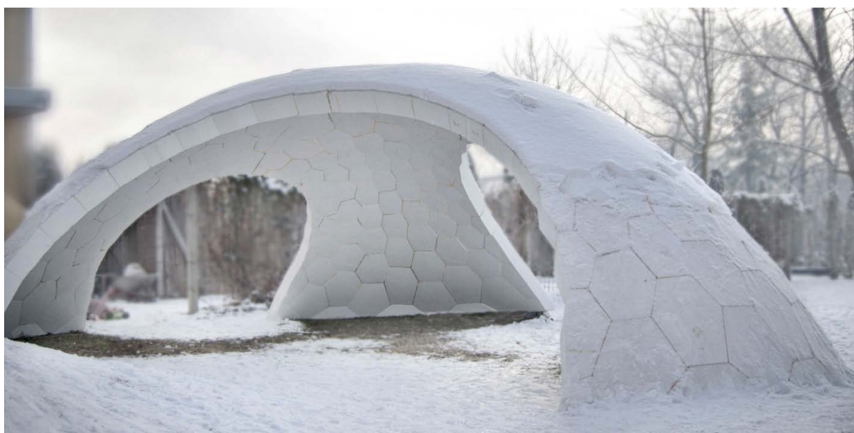
Slika 46 - Struktura na novoj lokaciji, nakon rasklapanja i ponovnog spajanja
