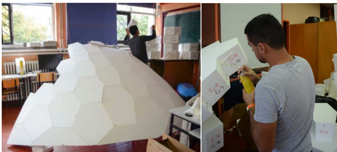
Slika 42 - levo - sklapanje jednog kraka van mesta postavke; desno - primene poliuretanske pene kao spojnog sredstva elemenata kraka
