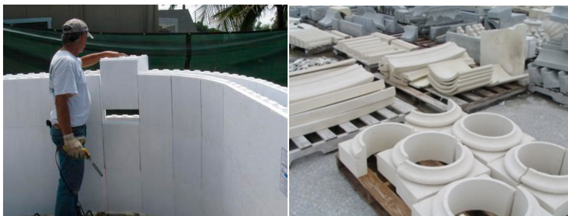
Slika 2 - levo - modularni elementi od penastog polistirena za potrebe izolacije (kompanija Fox Block Products , preuzeto februara 2017 sa www.foxblocks.com/products/fox-blocks/radius-block/ ); desno - različiti kalupi od penastih polistirena za potrebe generisanje gipsanih elemenata, ukrasa (kompanija Prekaston , preuzeto oktobra 2017 sa http://prekaston.com/ozelurunler.html )
