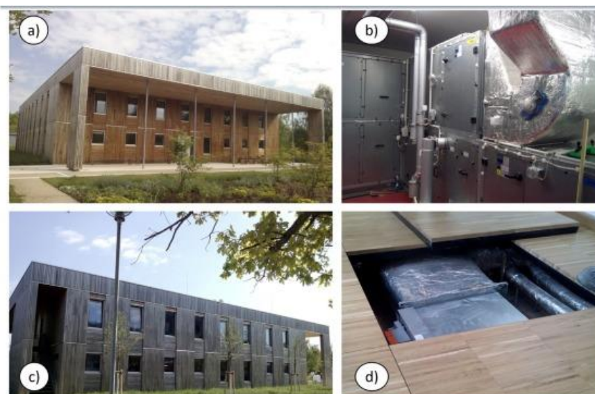
Slika 21. "Net zero energy" objekat UBA 2019: a) južna fasada, b) ventilaciona stanica, c) zapadna fasada, d) podni sistem za distribuciju vazduha
