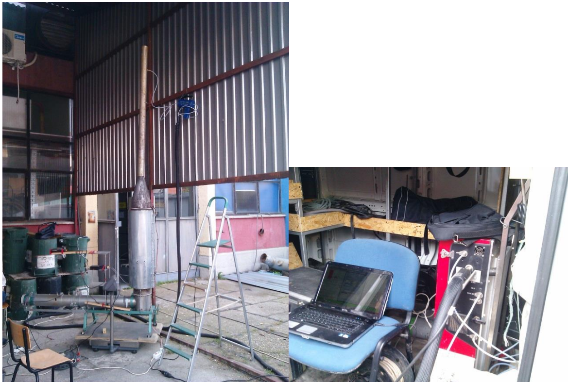
Slika 4.2: Merenje gasova na postrojenju
