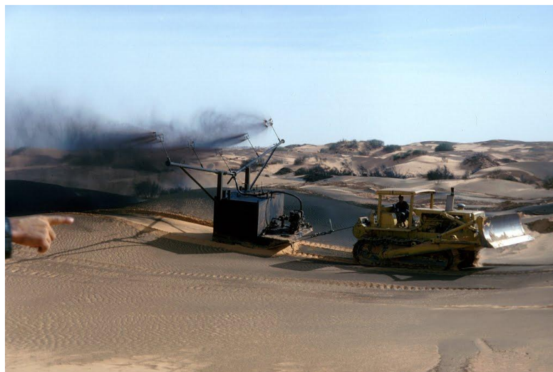
Slika 12. Fiksacija peščanih dina pomoću spreja od asfalta u obalnoj zoni u Libiji 1978. godine
