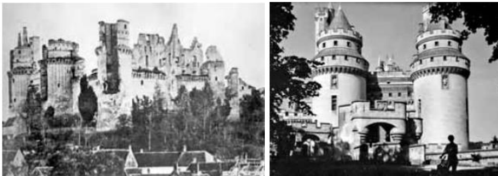
Ил. 3-79 Замак Пјерфон (фра. Pierrefontaine ) пре и после реконструкције Вијоле-л-Дика (фотографија десно снимљена је 1980.)
