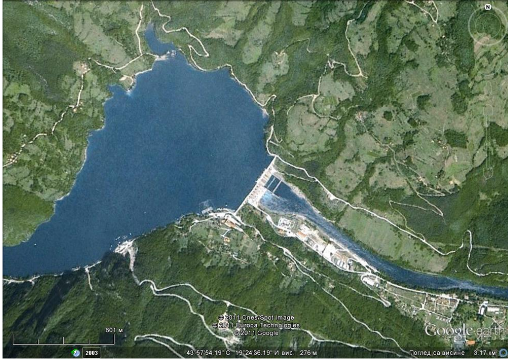
Slika 3. Hidroelektrana "Bajina Bašta" u Perućcu
