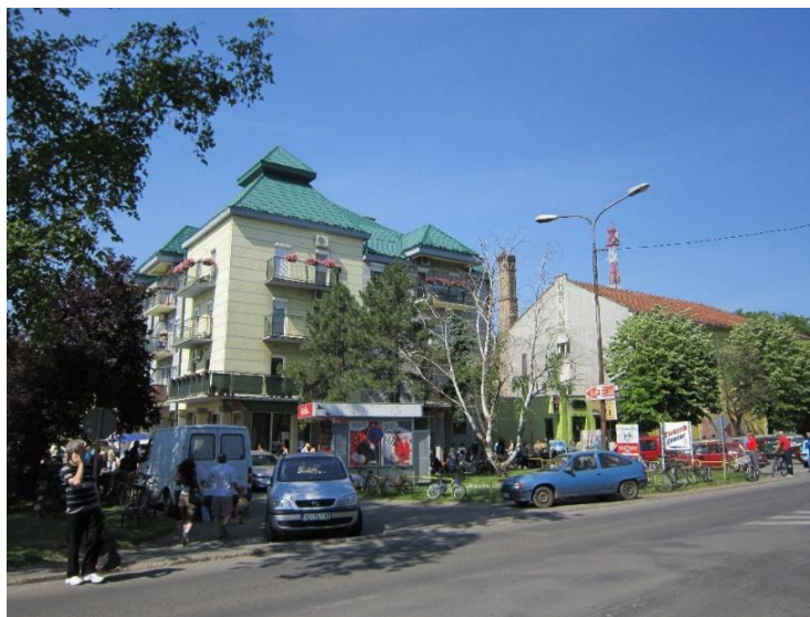
Slika 126: Jedina novoizgrađena struktura u centru Kule, u Ulici Maršala Tita.
