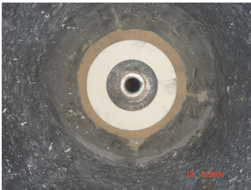
Slika 2.77. Postavljanje izolacionog prstena Unitherm
