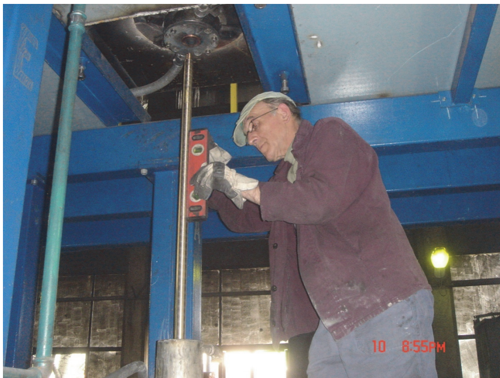
Slika 2.82. Nivelacija livne peći – vertikalna
