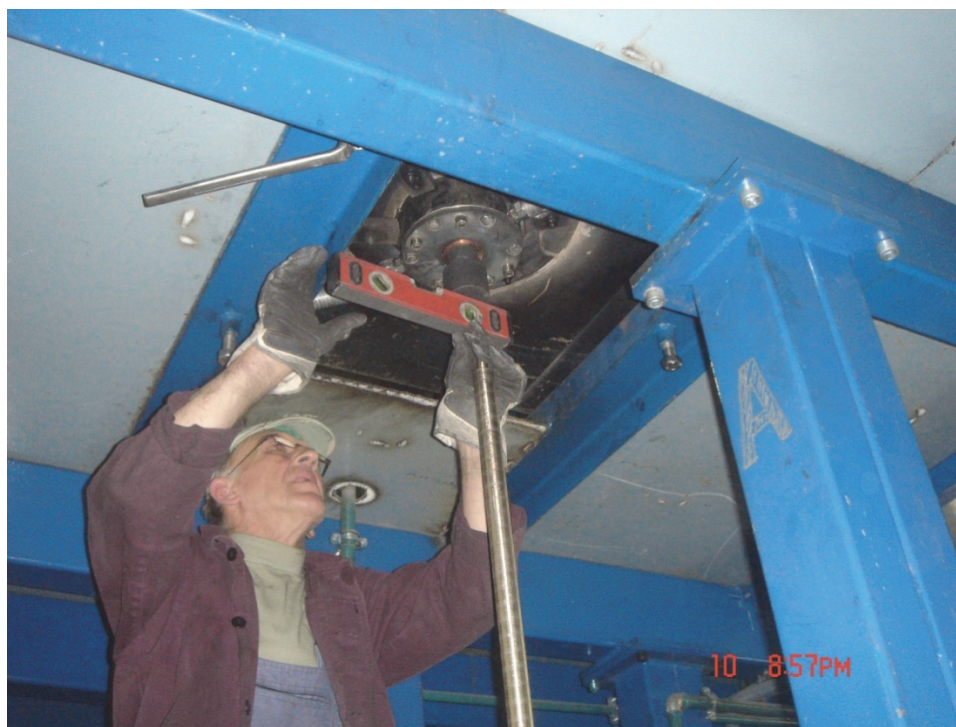
Slika 2.81. Nivelacija livne peći- horizontalna
