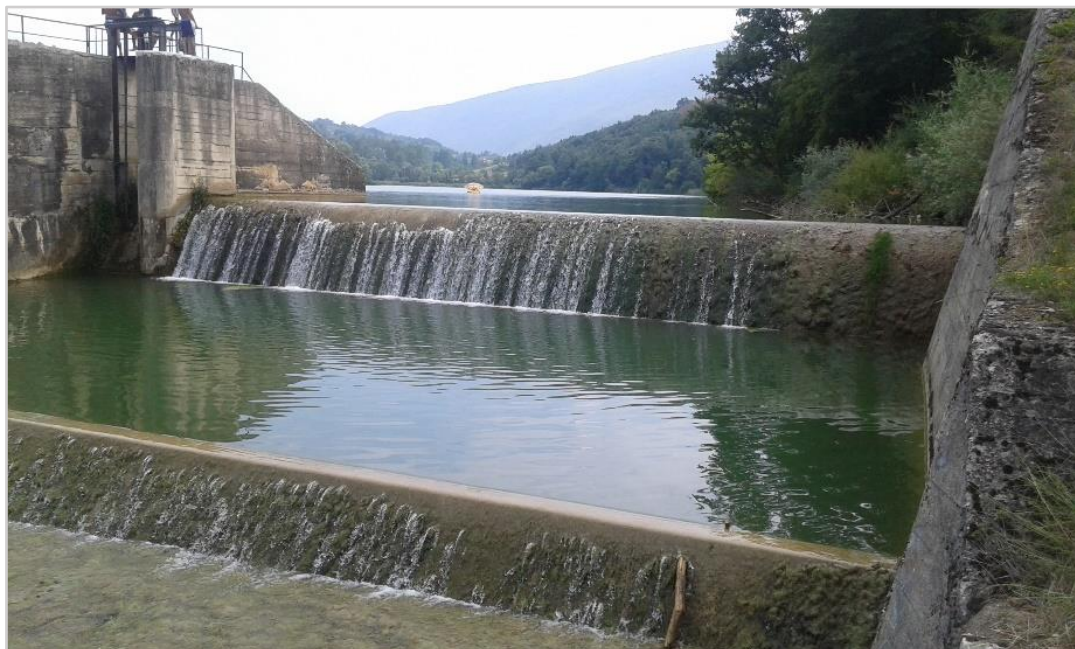
Слика 18. Базен-преливница за одржавање нивоа воде у језеру
