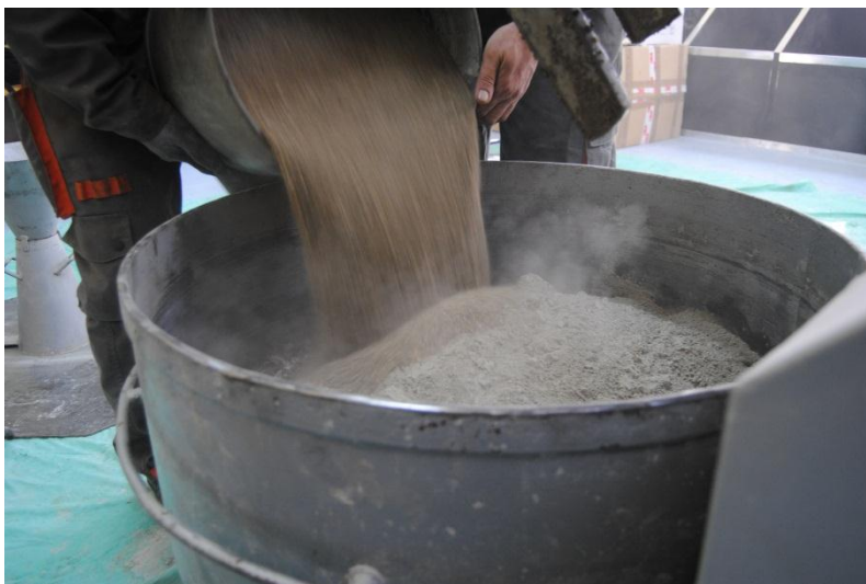
Slika VIII.10– Sipanje suvih komponenti u mešalicu
