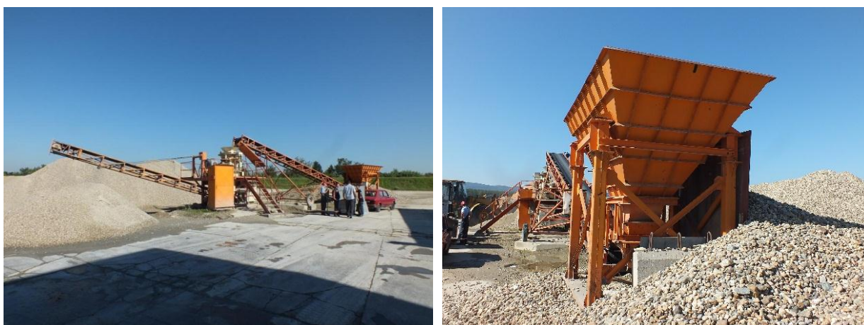
Slika VIII.4- Postrojenje za drobljenje kamena u Fabrici betona
