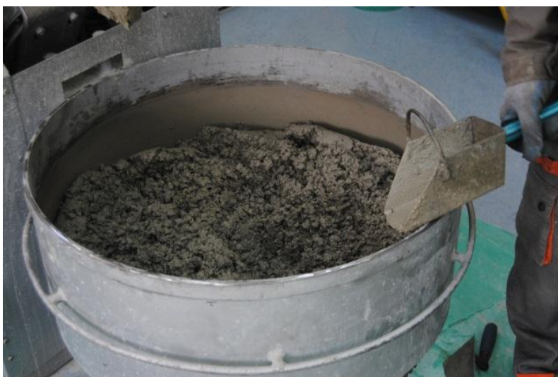
Slika VIII.11– Spravljena betonska mešavina
