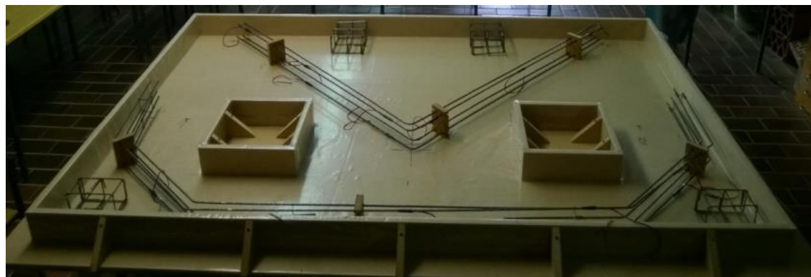
Slika 4.46 - Uzorak Z3 - postavljena armatura i merne trake na armaturi - pogled 2
