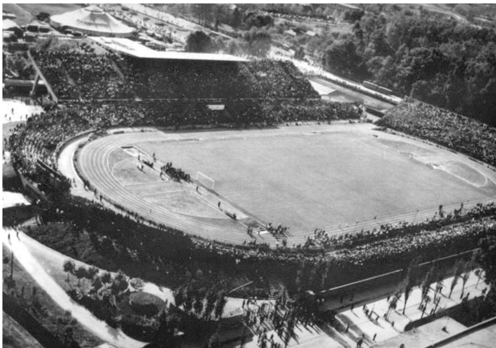
Слика 22, Стадион ФК „Динамо“ на Максимиру у Загребу, пре реконструкције (изграђен 1912). Извор: http://www.stadiumguide.com/maksimir/ .
