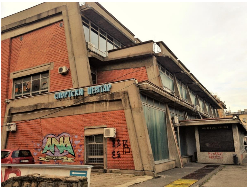
Слика 125, СЦ „Врачар“ (фотографија из 2015). Извор: приватна збирка.
