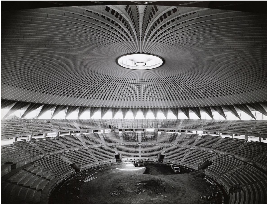
Слика 7, Дворана за спорт (Palazzo dello Sport) у Риму у току изградње. (пројектована 1956) Извор: http://www.bmiaa.com/pier-luigi-nervi-architecture-for-sport-at-maxxi-rome/ .
