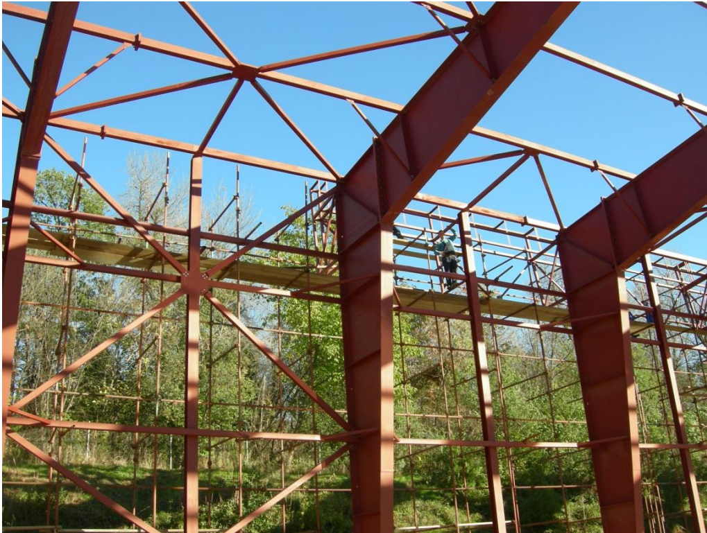
Слика 144, челична конструкција Атлетске дворане. Извор: Центропројект доо.
