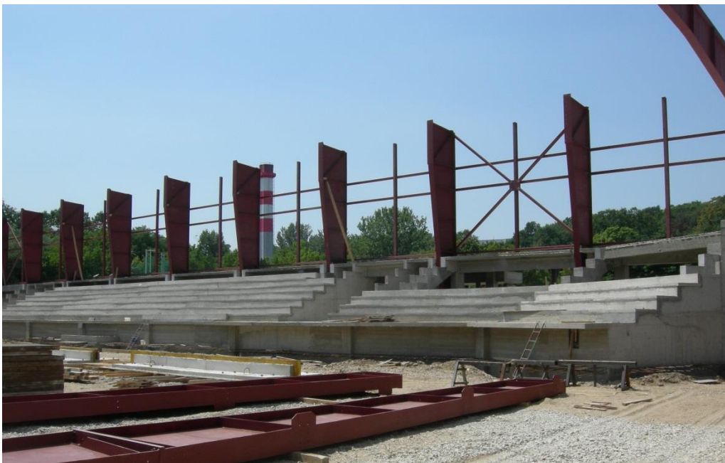
Слика 143, челична конструкција Атлетске дворане. Извор: Центропројект доо.
