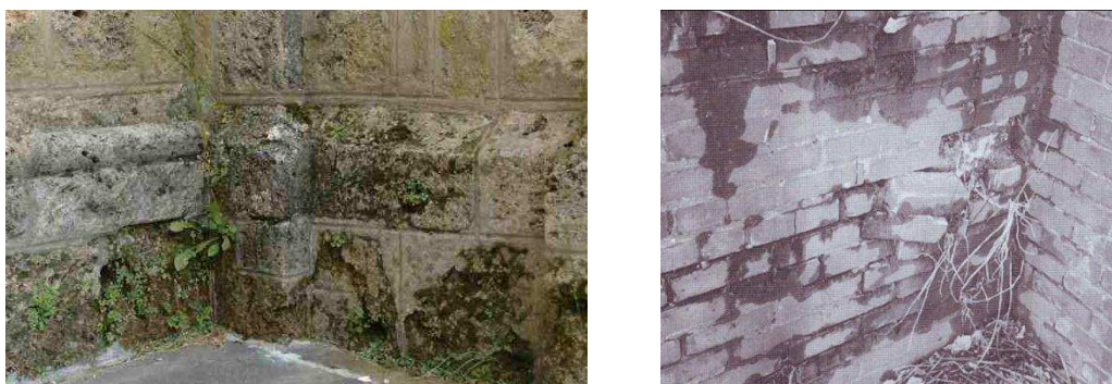
Slika 5.15 Oštećenja zidova nastala usled uticaja spoljašnje sredine
