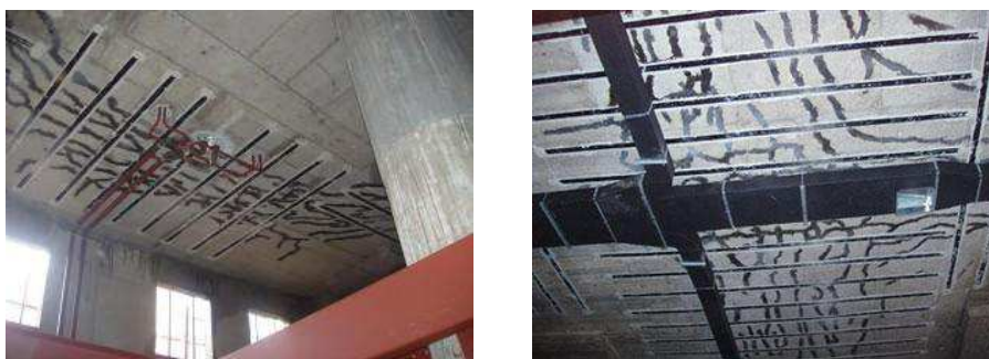
Slika 5.52 Ojačanje međuspratnih konstrukcija karbonskim laminatima
