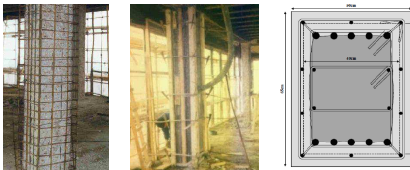
Slika 5.44 Izvođenje betonske obvojnice oko stuba [www.grf.bg.ac.rs/p/learning/2_prezentacija_sanacije_i_ojavanja_1387902455865.pdf, preuzeto 03.2016.]
