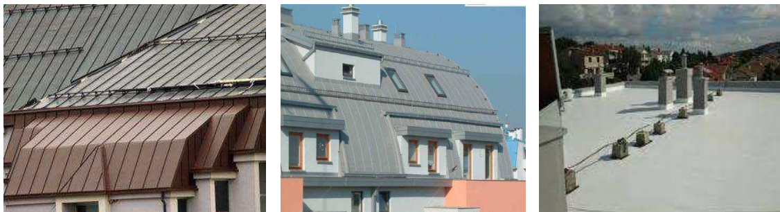
Slika 5.53 Izgled kosih i ravnih krovova
