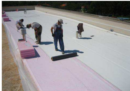
Slika 5.61 Radovi na sanaciji i obnavljanju slojeva ravnog krova
