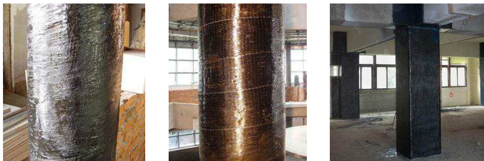
Slika 5.42 Primena karbonskih traka pri ojačavanju armiranobetonskih stubova [www.buildmagazin.com, preuzeto 04.2016.]
