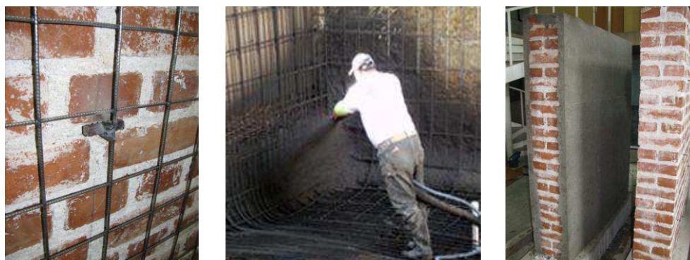
Slika 5.22 Faze nanošenja torkret betona
