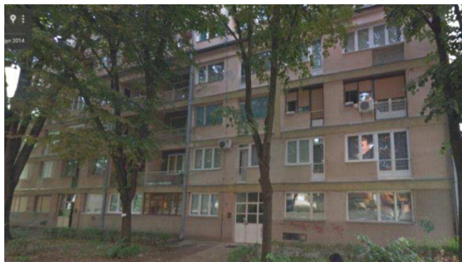
Slika 6.4 Frontalna-ulična fasada jednog od objekata "tipa A" (ul. Rentgenova)
