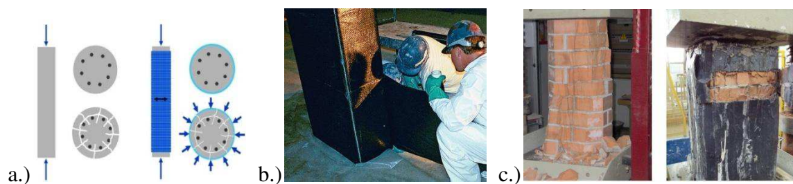
Slika 5.26 Saniranje stuba obvojnicom od FRP traka [Gattesco, 2011]
