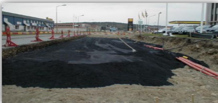
Slika 16. Rekonstrukcija ulice korišćenjem granulirane šljake – Boliden Iron Sand
