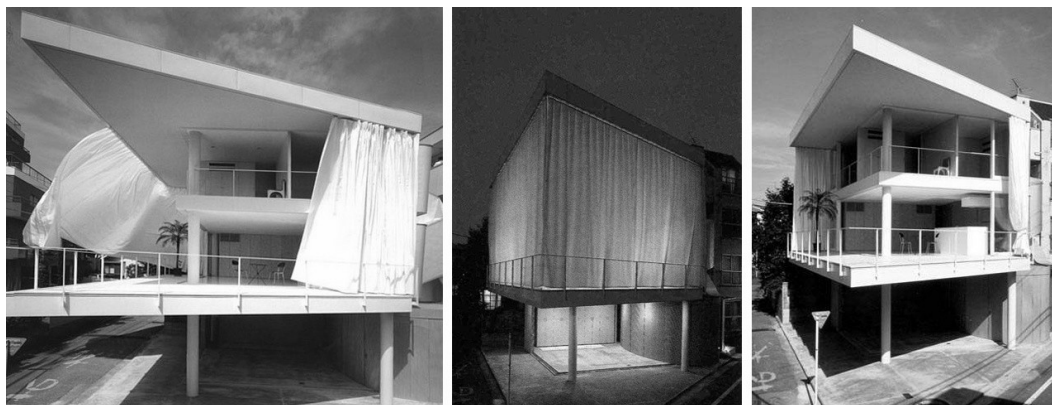
Слика 8.2.2.3. – трансформација опне објекта без промене габарита, применом принципа ширења / скупљања; Шигеру Бан, „ Curtain Wall “ кућа, Токио, Јапан, 1995.
