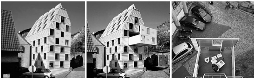
Слика 8.2.4.4 – трансформација опне објекта са променом габарита, применом принципа извлачења / увлачења; Seifert and Stoeckmann, Living Room house , Немачка, 2005.
