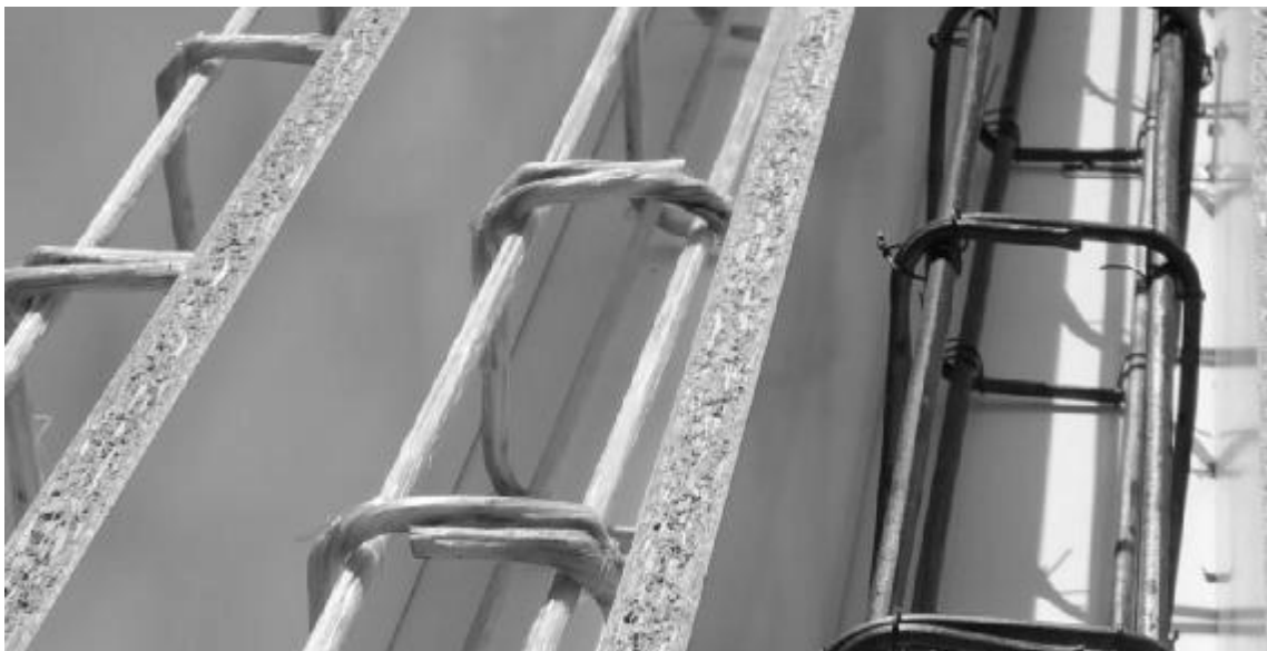
Слика 33. Арматурни кошеви у калупу пре ливења бетонске смеше
