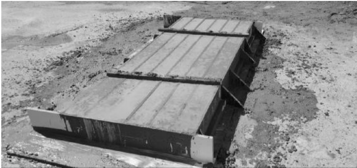
Слика 37. Изливени бетон у калупу
