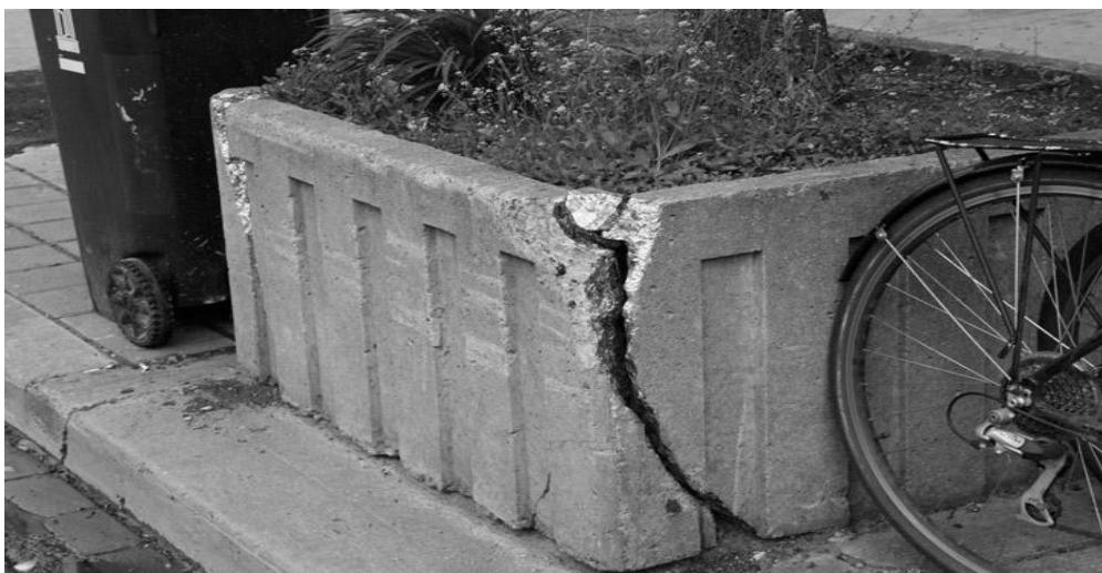
Слика 65. Деградација бетона услед утицаја корозије и инцидентног оптерећења 39
