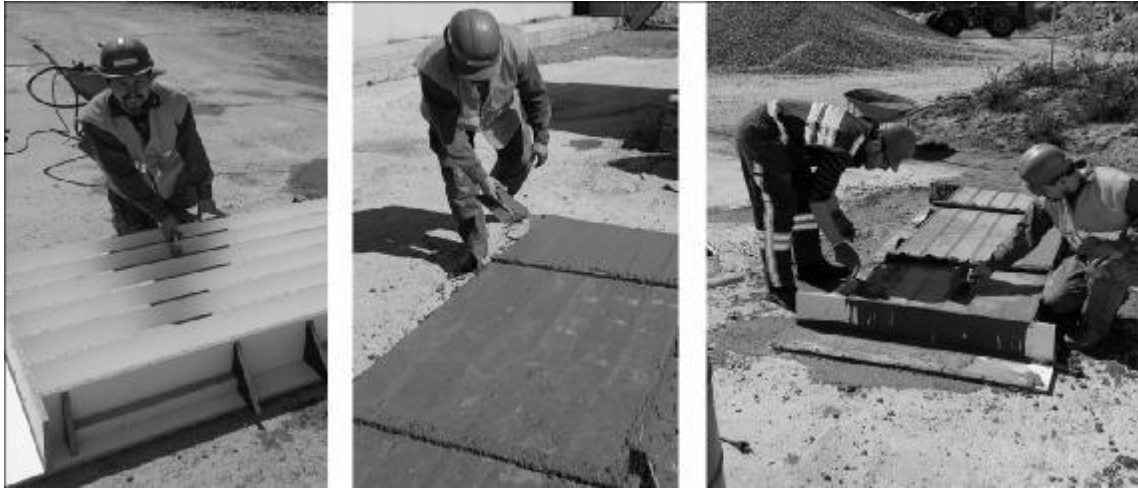
Слика 34., 35. и 36. Ливење бетона у калупе
