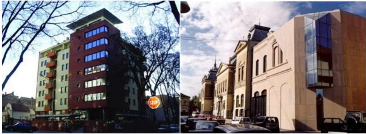
Sl. 56, 57 Stambeni objekat, Radnička ulica, arhitekta Leonid Nešić, 2003., Dogradnja zgrade Matice Srpske, arhitekta Milan Marić, 2003.
