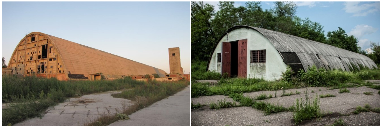
Sl. 63,64 Agrohem, Industrijska zona duž kanala Dunav-Tisa –Dunav, Vojni magacin u podgrađu Petrovaradinske tvrđave
