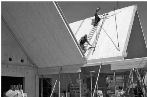
Слика 17. Конструкција косог крова [100]
