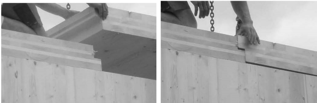
Слика 21 а и б. Процес извођења хоризонталне везе две таваничне CLT плоче [100]
