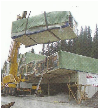
Слика 57 а и б. Монтажа просторних јединица и изглед готове зграде Camp Wildalpen [50]
