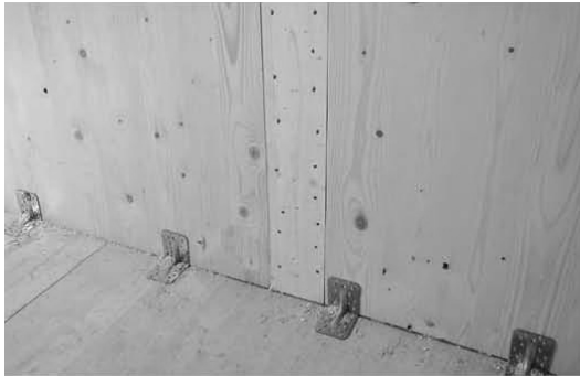
Слика 23. Изглед вертикалне везе CLT плоча [100]
