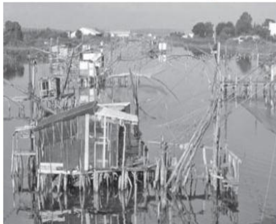
VODA IZ SOLANE PRIVREMENO RJEŠAVA PROBLEM: Port Milena
