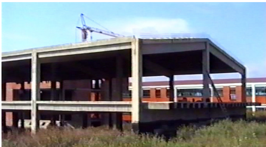
Sl. 7.17 Izgled objektata Nini samo skelet-objekat B1 i završena hala-objekat B2.
