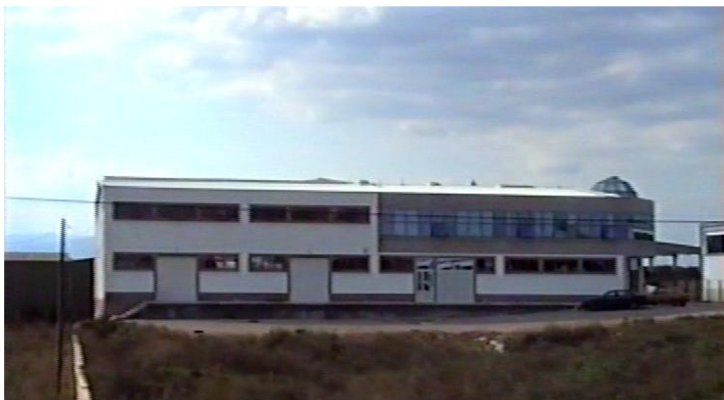
Sl. 7.14 Izgled hale Ekotrade-objekat A
