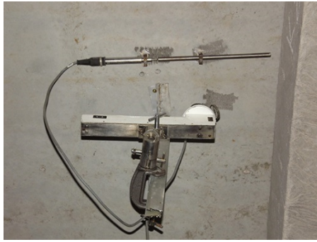
Sl. 6.12 Montaža klinometra K2 i dilatometer D1.
