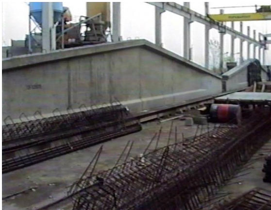
Sl. 9.5 Nosači A-30 na stazi za prednaprezanje i betoniranje.
