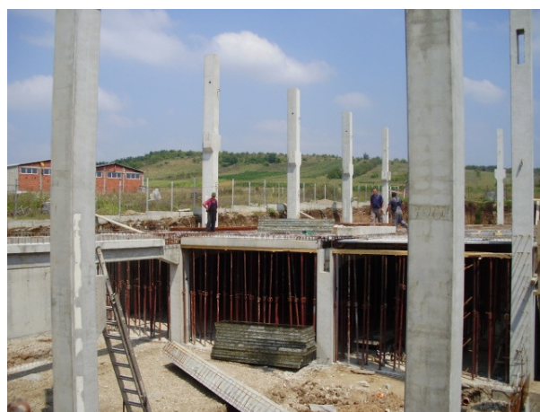
Sl. 6.6 Stubovi i međuspratna konstrukcija OMNIA u pogonu Putinženjeringa i na gradilištu Lovoprometa u fazi montaže
