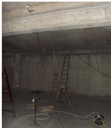
Sl.6.14 Montirani instrumenti za pru fazu-ispitivanje međuspratne konstrukcije.
