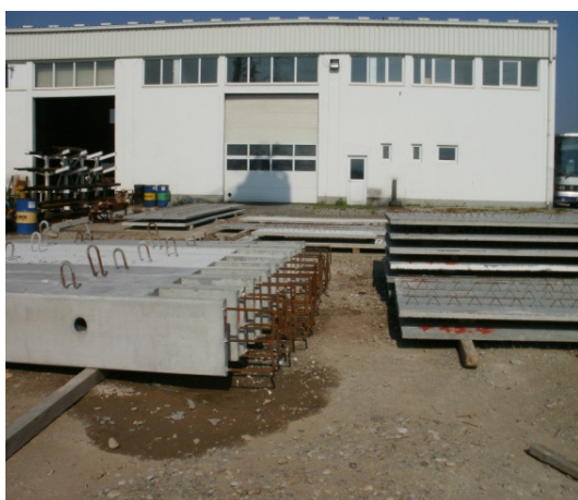
Sl. 6.6 Stubovi i međuspratna konstrukcija OMNIA u pogonu Putinženjeringa i na gradilištu Lovoprometa u fazi montaže
