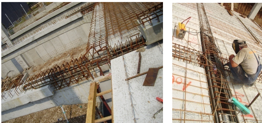
Sl. 6.8 Kontinuiranje greda na objektu Lovopromet
