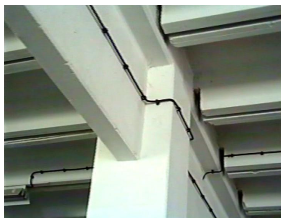
sl.7.24 Izgled konstrukcije hale Elektrotehna iznad prizemlja
