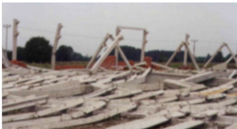
Sl. 8.4a Karakterističan primer oštećenja za vreme zemljotresa u Turskoj: Detalji totalno srušenih objekata.
