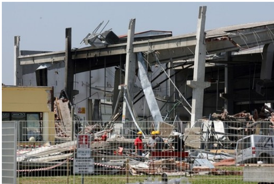
sl. 8.5e Karakterističan primer oštećenja za vreme zemljotresa u Italiji:
