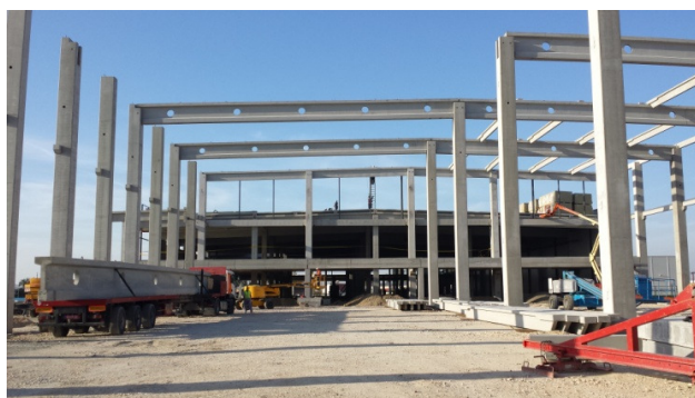
Sl. 5.5 Konstrukcija objekta u fazi montaže
