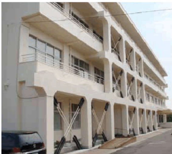
Sl. 8.2 Karakterističan primer oštećenja za vreme zemljotresa u Japanu: Oštećenja veza celog objekta uslovila su intervencije za ojačanje.
