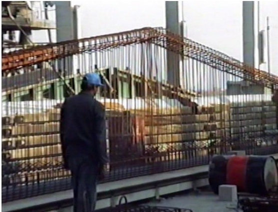
Sl. 9.1 Armatura nosača A-30.
