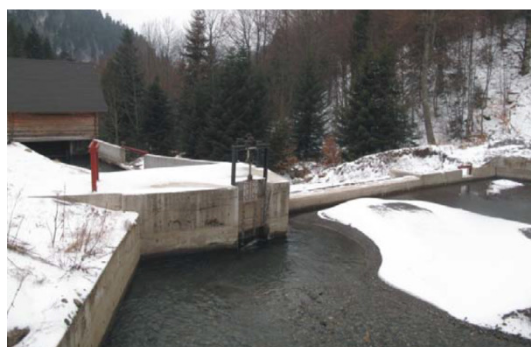
Slika 5.7. Izgrađena MHE 2 u gornjem toku Vrbasa
