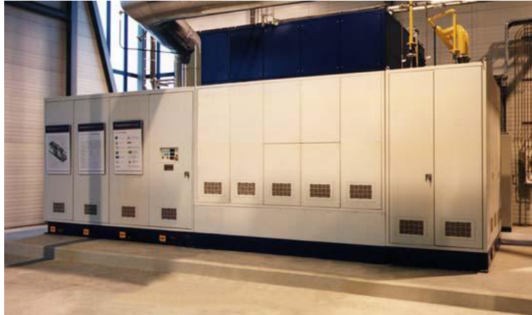
Slika 13. Westinghouse/Siemens Tubular Cell 100 kW CHP Sistem sa 1176 SOFC. Proizvodi 100 kW AC struje i toplu vodu, a radi na prirodni gas. Ima preko 36,890 radnih sati u USA, Holandiji, Nemačkoj i Italiji sa beznačajno malom degradacijom performansi ( < 0.1\% po 1000 h).
