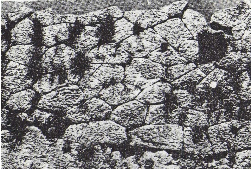
Слика 163: Пљоч – лице бедема од полигоналних блокова (Anamali 1972a, Pl. 4a).
