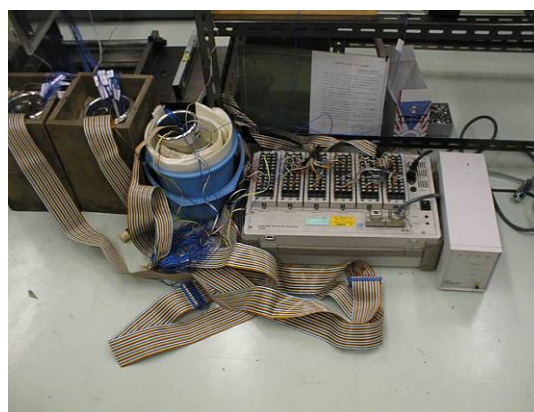
Slika 4-17 Data-logger i multiplekser za očitavanje sa termoparova
