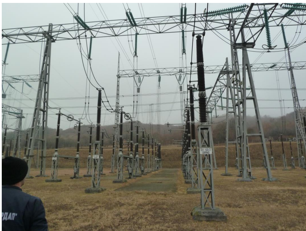
Slika 10.11: Fotografija distributivnog polja 400 kV Beograd
