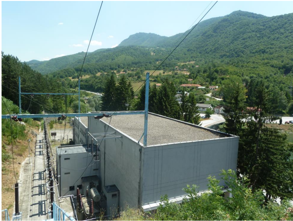
Slika 10.25: Fotografija mašinske zgrade i blok transformatora HE "Bistrica"
