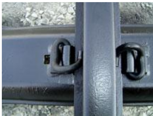
Slika 14. Pričvrtni materijal kod čeličnih železničkih pragova [40]
