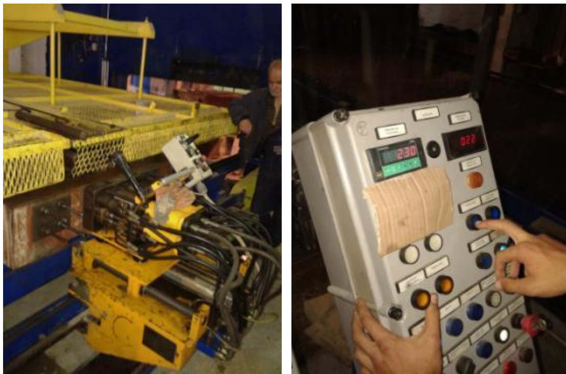
Slika 110.a) i 110.b) Unošenje sile prednaprezanja
