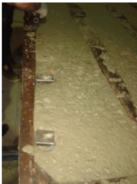
Slika 111. Betoniranje pragova u kalupima sa obezbeđenjem izvoda mernih traka
