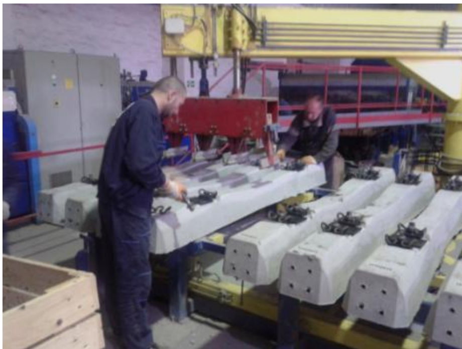
Slika 11. Prednapregnuti betonski železnički prag- montaža veznog pribora-Betonjerka Stalać
