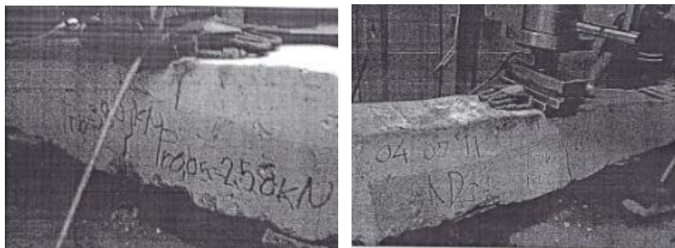
Slika 104.a) i 104.b): Dinamičko ispitivanje preseka na mestu oslanjanja šine posle perioda eksploatacije
