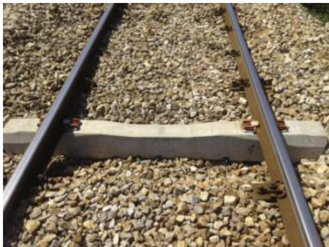
Slika 155. Prag B70, L=240cm, montiran u kolosek u blizini betonjerke u Stalaću
