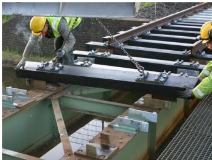
Slika 17. Montaža kompozitnog železničkog praga
