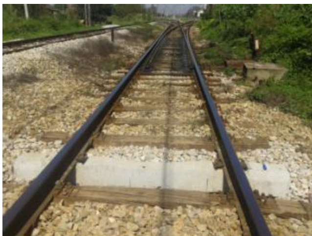
Slika 113. Prag B70, L=260cm, montiran u kolosek u blizini žel. stanice u Stalaću, pred početak skretnice
