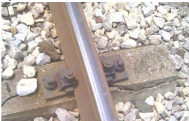
Slika 6. Naprsli prag koji je još uvek u eksploataciji
