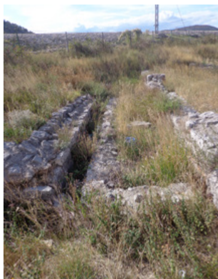
51. VELIKE TERME, PROSTORIJA 23 SA ZIDANIM KANALOM ZA VODU DUŽ JUŽNOG ZIDA FOTO T. KOPRIVICA (2015)
