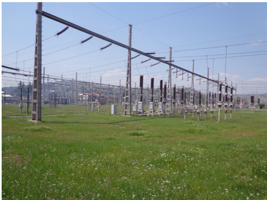
2. TRAFOSTANICA IZNAD JUGOISTOČNE NEKROPOLE FOTO: T. KOPRIVICA (2013)
