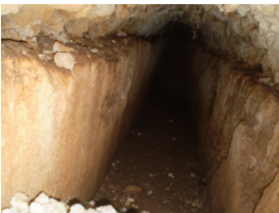
7. UNUTRAŠNJUST VODOVODA, FOTO M. BAKOVIĆ (2012)
