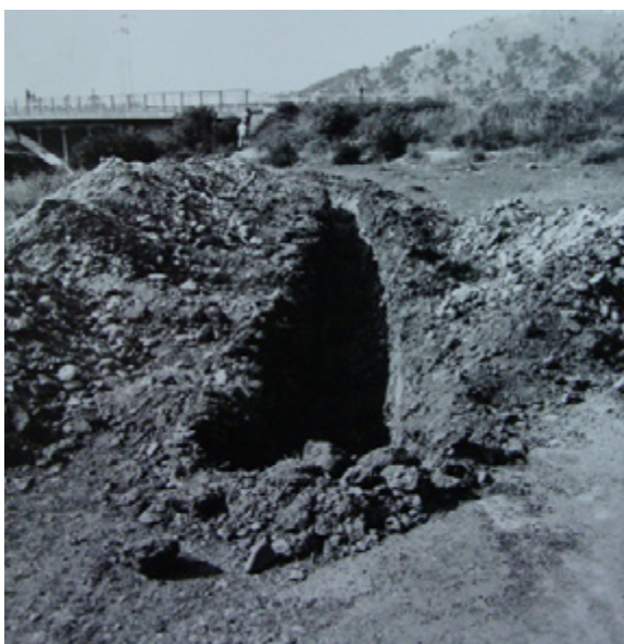
6. JUŽNI DIO GRADA, KANAL ZA VODOVOD (1994), FOTO: NEPOZNATI AUTOR UPRAVA ZA ZAŠTITU KULTURNE BAŠTINE CRNE GORE
