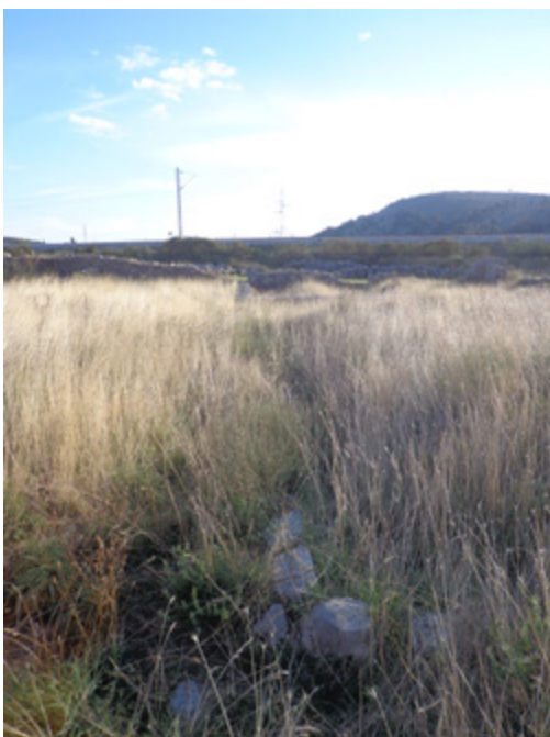
101. ISTOČNI ZID U PRODUŽETKU GRAĐEVINE 2 FOTO: T. KOPRIVICA (2015)
