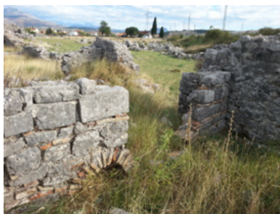
90. GRAĐEVINA 2 PROSTORIJA 2, ISTOČNI ZID FOTO: T. KOPRIVICA (2015)
