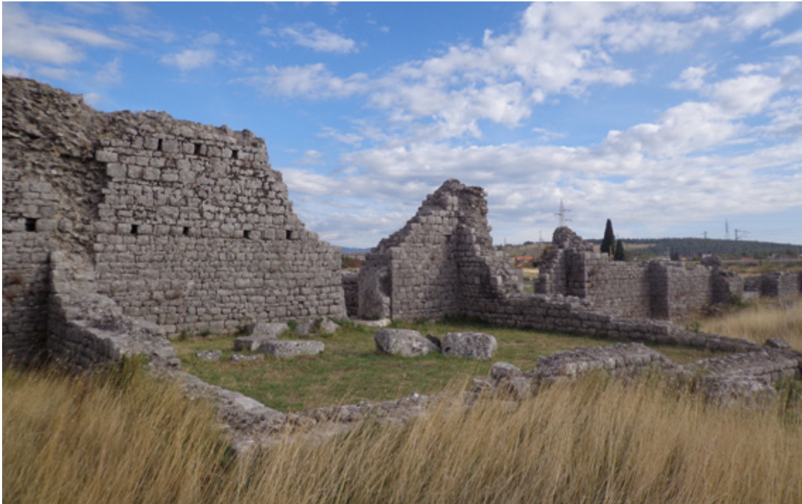
72. ZAPADNA STRANA BAZILIKE, PROSTORIJA POVEZANA SA PROSTORIJOM D BAZILIKE FOTO: T. KOPRIVICA (2015)
