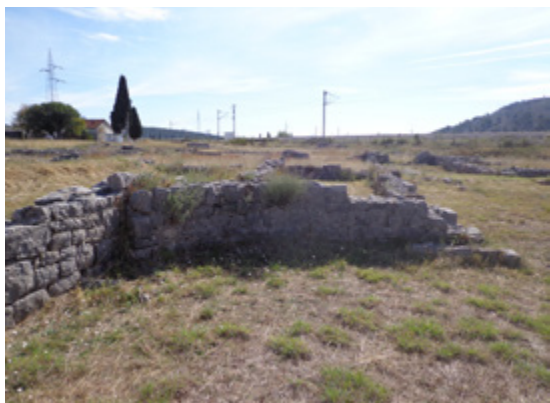
11. VELIKE TERME, PROSTORIJA 1, ISTOČNI ZID I DOZIDANA NIŠA NA JUŽNOJ STRANI FOTO: T. KOPRIVICA (2015)
