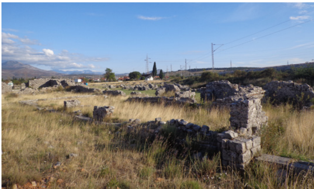
85. GRAĐEVINA 2 (POGLED SA JUGA) FOTO: T. KOPRIVICA (2015)
