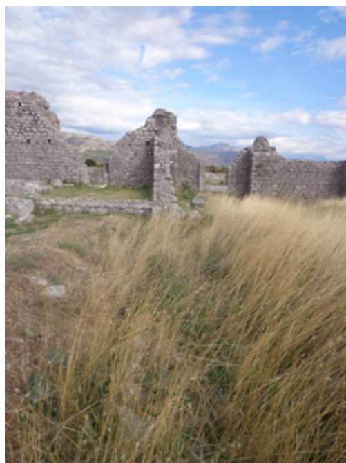
102. ZID U PRODUŽETKU GRAĐEVINE 2 KOJI JE POVEZUJE SA PROSTORIJOM UZ BAZILIKU FOTO: T. KOPRIVICA (2015)
