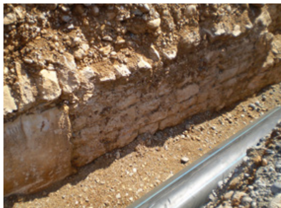
8. UNUTRAŠNJUST VODOVODA, FOTO M. BAKOVIĆ (2012)
