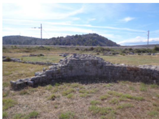
12. VELIKE TERME, PROSTORIJA 1, ZAPADNI ZID I NIŠA NA JUŽNOJ STRANI FOTO: T. KOPRIVICA (2015)
