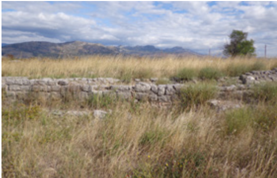
78. VELIKE TERME, PROSTORIJA 35 VRATA U ISTOČNOM ZIDU ZAZIDANA U POSLEDNJOJ GRADITELJSKOJ FAZI FOTO: T. KOPRIVICA (2015)
