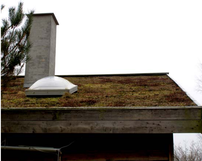
слика 17: село Дусекиле – детаљи зеленог крова; фотографија: Ксенија Буњак, март 2012. године
