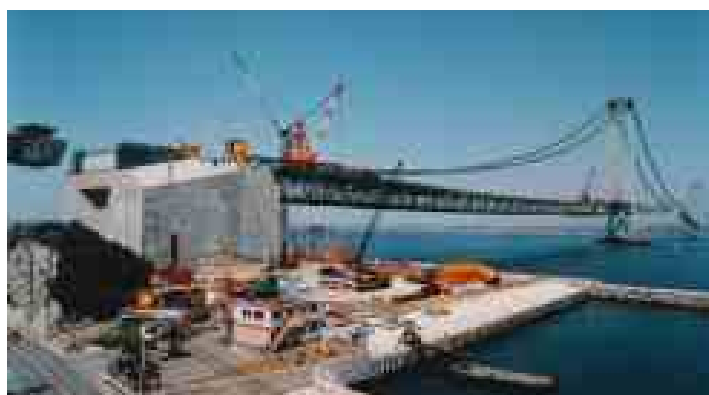
Slika 1.5 Ankerni blok (u izgradnji) mosta "Akashi-Kaikyo" [197]
