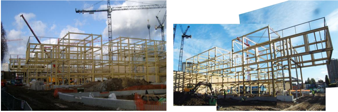
Слика 2.7: "Bourbon Lane" – челична скелетна конструкција на армирано-бетонским темељима Извор: http://www.cartwrightpickard.com/sectors/environment/288_bourbon-lane.aspx , 02.01.2013.
