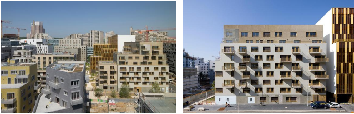
Слика 2.29: Новопроектовани квартал у Булоњ-Бијанкуру (лево) и објекат JPC "ZAC Seguin" (десно)
