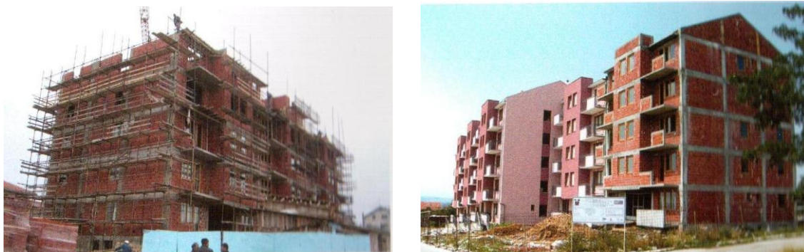
Слика 3.10: Објекти ЈРС у Нишу – у изградњи
