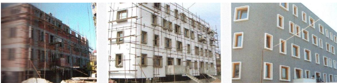
Слика 3.30: Објекат у насељу Сретена Дудића – материјализација фасаде
