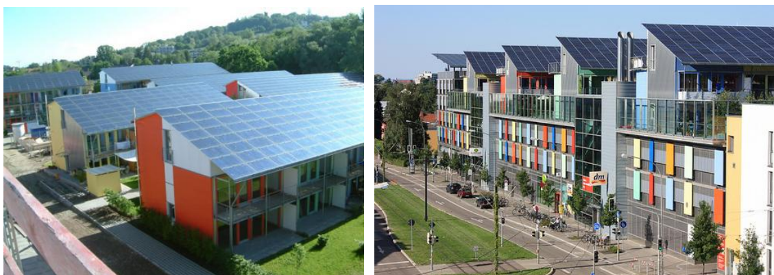
Слика 2.18: Ваубан, Фрајбург - Соларни панели као кровни покривач
