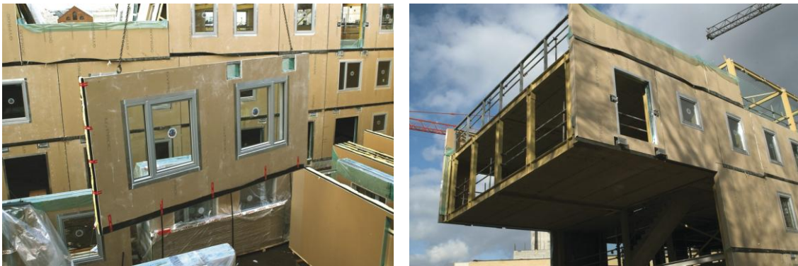
Слика 2.8: "Bourbon Lane" – фасада је израђена од префабрикованих панела Извор: http://www.cartwrightpickard.com/sectors/environment/288_bourbon-lane.aspx , 02.01.2013.
