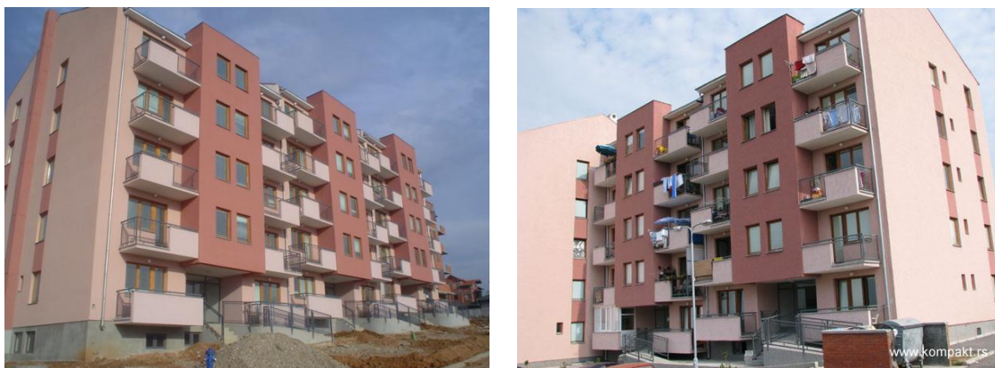
Слика 3.8: Објекти ЈРС у Нишу
