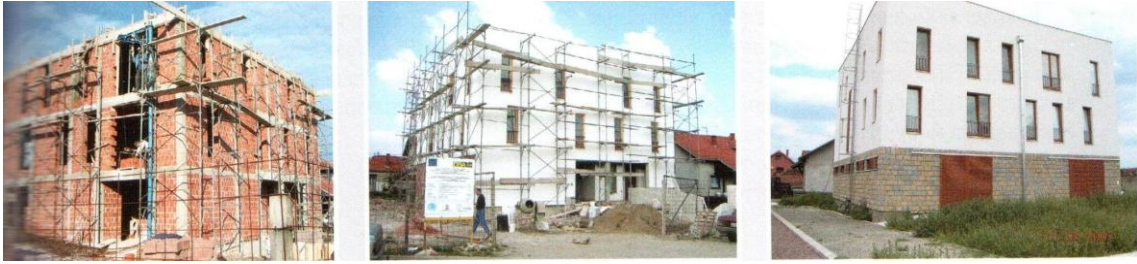
Слика 3.26: Објекат у Новом Насељу – у изградњи
