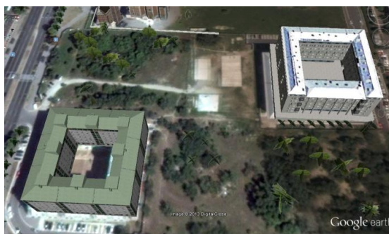
3Тс (3_ТВРЂАВА_сегрегација) /блок 33 – изграђени стамбени део
