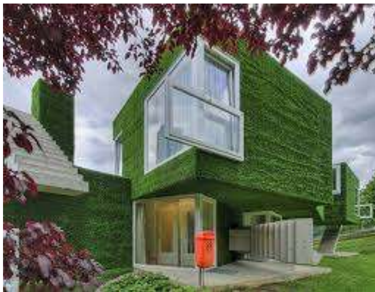
Слика 81. Пример озелењене фасаде
