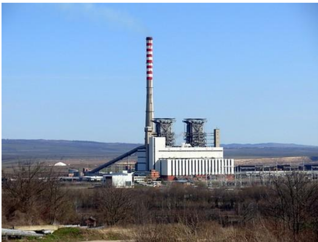
Slika 4.6.- Termoelektrana Kostolac B, blokovi B1 i B2
