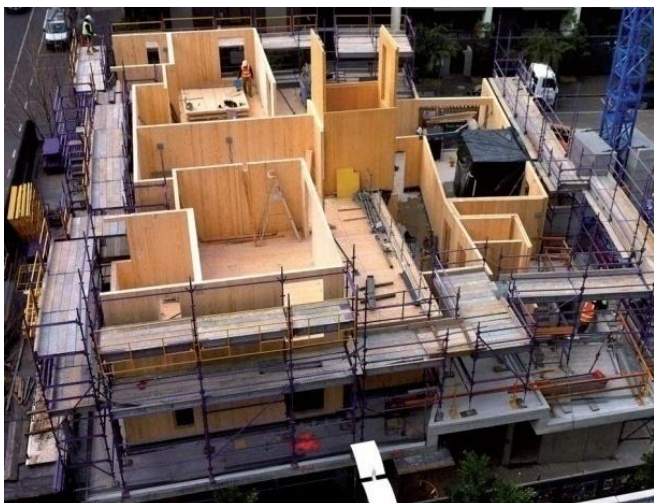
Slika 18. Detalj gradnje najviše zgrade od CLT-a Forte (Izvor: www.timber-building.com )
