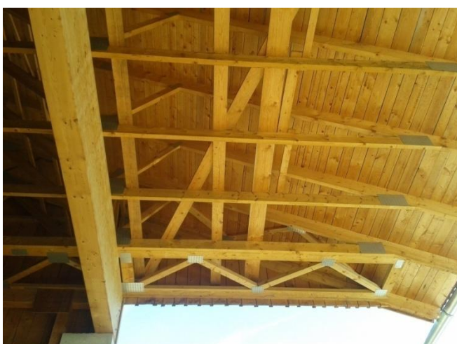
Slika 25. Krovna konstrukcija od drvnih kompozita (Izvor: Sretenovic P., okolina Minhena, 2013)
