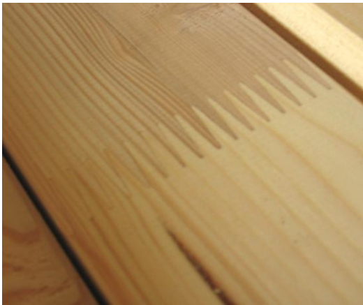
Slika 37. Zupčasti spoj rendisanih lamela ( Sretenovic P., 2015)
