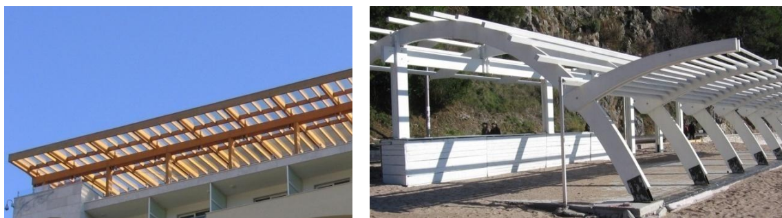
Slike 54. i 55. Nadstrešnica hotela Splendid od ravnog LLD-a (levo) i zakrivljenog LLD-a (desno) na crnogorskom primorju (Izvor: Sretenovic P., 2011)
