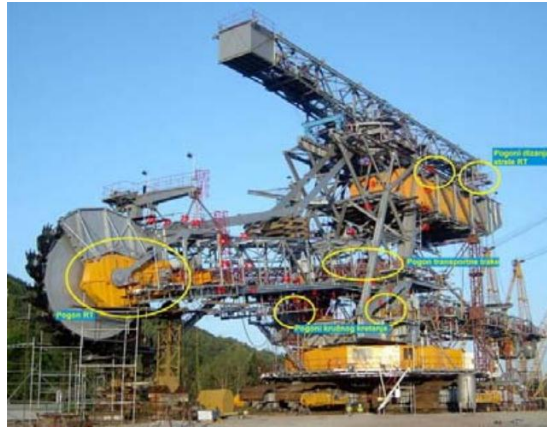
Slika 4.28. Merna mesta na kojima se prate naprezanja u konstrukciji i vibracije ležajeva na svim bitnijim pogonima bagera [3,204]
