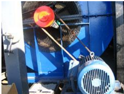
Slika 5.4. Neparalelnost i nesaosnost remenica pogonske (elektromotora) i gonjene mašine [94]
