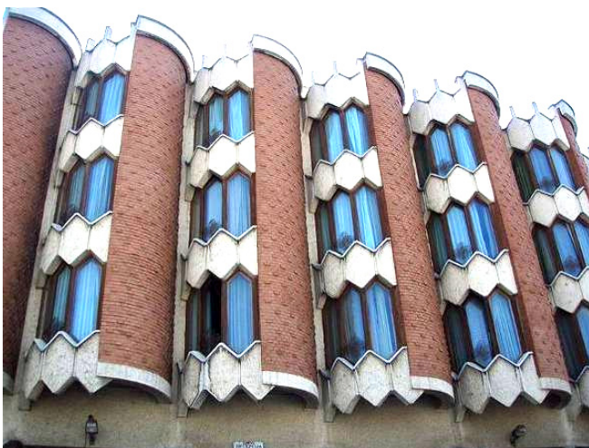
Слика 58г,д. Детаљи фасаде (Извор: приватна колекција аутора рада)
