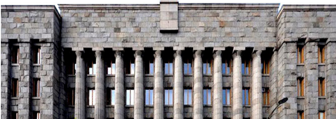
Слика 39в. Груба буњаста обрада фасаде (Извор: приватна архива аутора рада)
