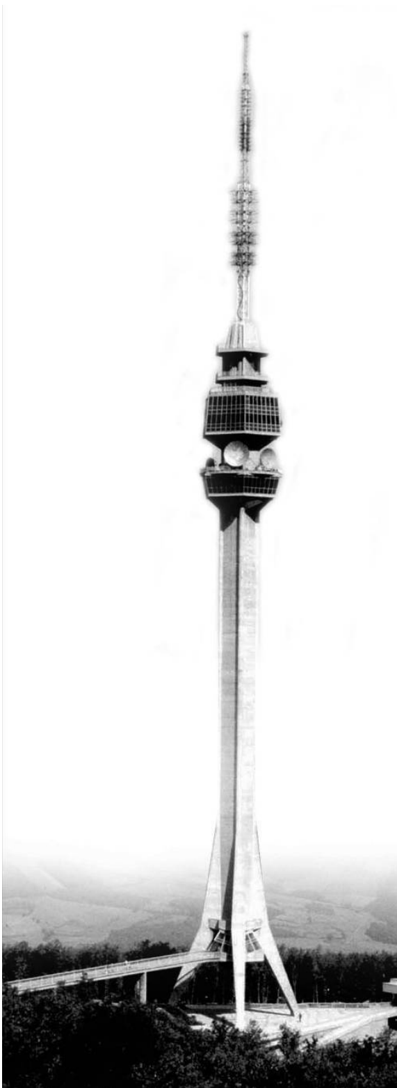
Слика 46а. Телекомуникациони торањ на Авали у Београду, Угљеша Богуновић, Слободан Јањић, 1965. (Извор: Злоковић, Ђорђе. „Телевизијски и УКТ торањ на Авали крај Београда”. Архитектура урбанизам (Београд), бр. 40 (1966), стр. 22).
