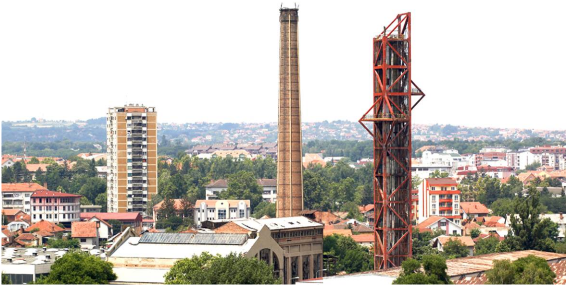
Слика 72а. Торањ за технолошку воду „ТЕЦ 2” у Крагујевцу, 1981. (Извор: приватна архива, фото Б.Митровић)
