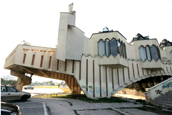
Слика 58б. Сегмент фасаде угоститељског блока (Извор: приватна колекција аутора рада)
