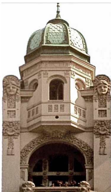
Слика 13б. Деталј куполе (Извор: Живановић, Душица. Архитекта Милорад Рувидић: Живот и дело . Београд: Орион арт, 2004.)
