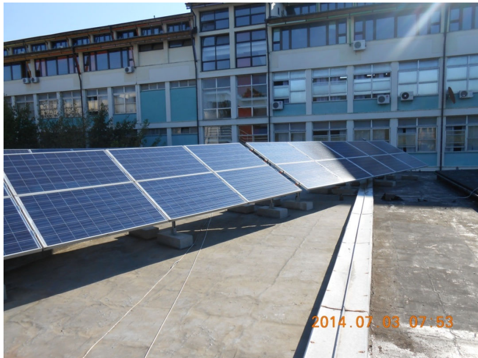
Slika 8.7 – Delimično senčenje južnog FN niza u prepodnevnim satima u elektrani FTN-NS
