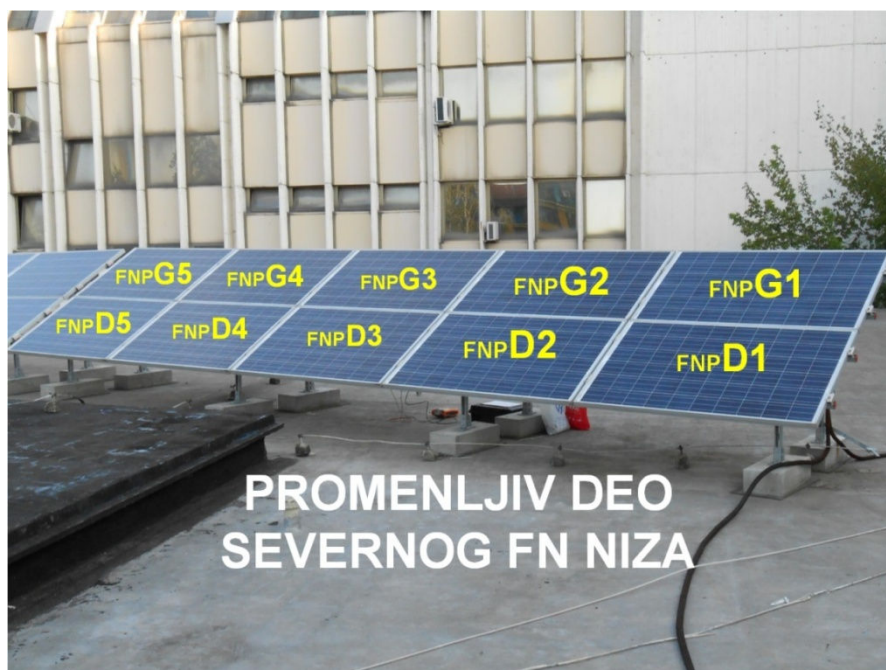
Slika 8.6 – Obeleženi FN paneli promenljivog, rekonfigurabilnog severnog FN niza
