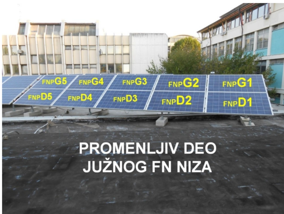
Slika 8.5 – Obeleženi FN paneli promenljivog, rekonfigurabilnog južnog FN niza
