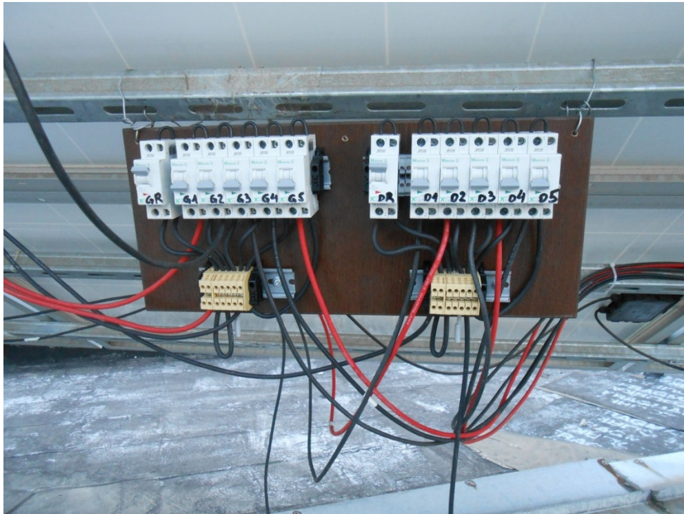
Slika 8.11 – Hardver postavljen ispod FN niza za izvođenje mikrorekonfiguracije
