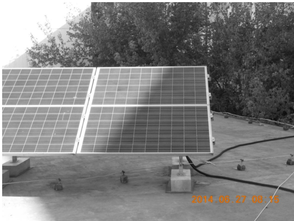
Slika 8.8 – Izlazak iz senke poslednjih panela severnog FN niza
