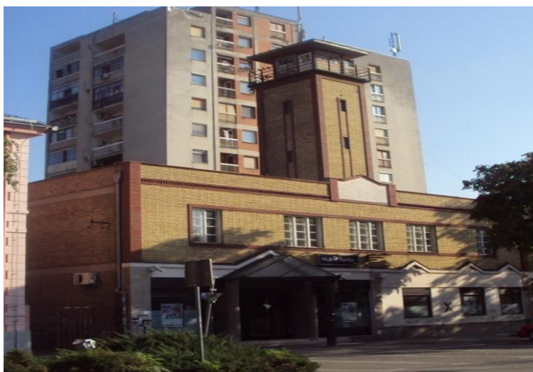
Сл. 679: Зграда водоторња у Врбасу, 1937. Извор: аутор рада
