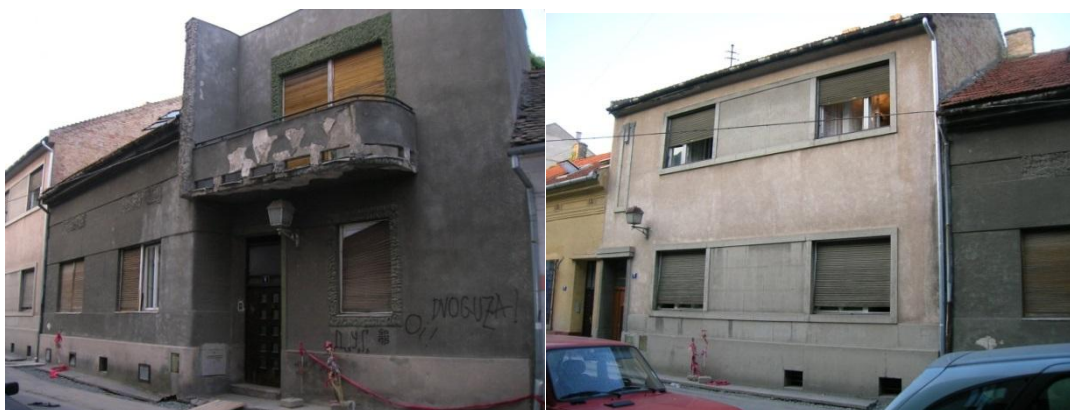
Сл. 582 и 583: Куће у Гајевој улици 4 и 6 у Новом Саду, четврта деценија двадесетог века. Извор: аутор рада
