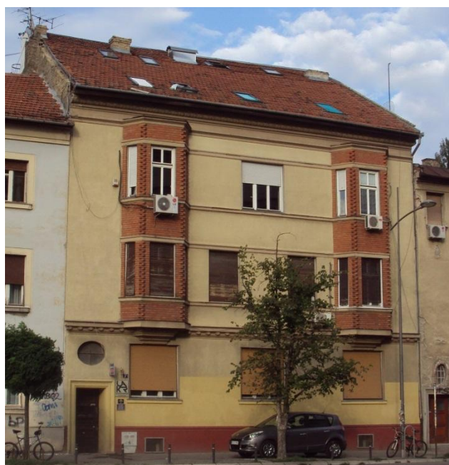
Сл. 528: Ђорђе Табаковић, Зграда у Стражиловској 7 у Новом Саду, 1930/31. Извор: аутор рада
