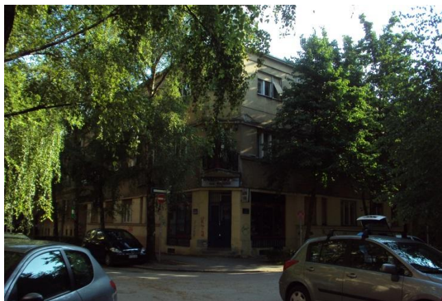
Сл. 556: Зграда на углу улица Јована Бошковића и Илије Вучетића у Новом Саду, четврта деценија двадесетог века. Извор: аутор рада
