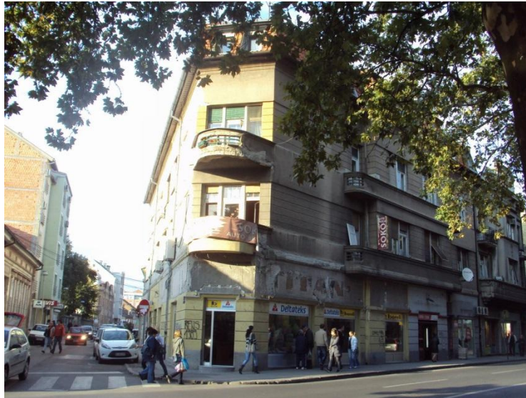
Сл. 503: Јосиф Шверер, Зграда на углу Јеврејске и Шафарикове у Новом Саду, 1931. Извор: аутор рада
