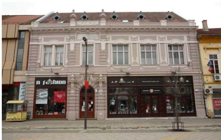
Сл. 16: Торонталска банка у Зрењанину, 1803. Извор:: http://www.zrenjaninheritage.com/zgrada-prve-hrvatske-stedionice-torontalska-banka .
