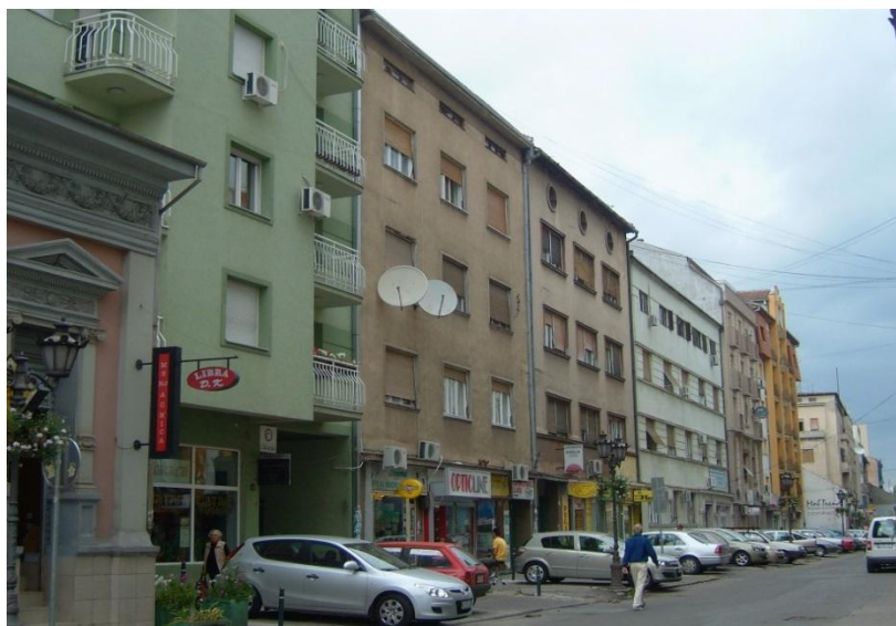
Сл. 744: Низ зграда у Железничкој улици у Новом Саду. Зграда са окулусима на броју 42, (Павле Цоцек 1939). Извор: аутор рада
