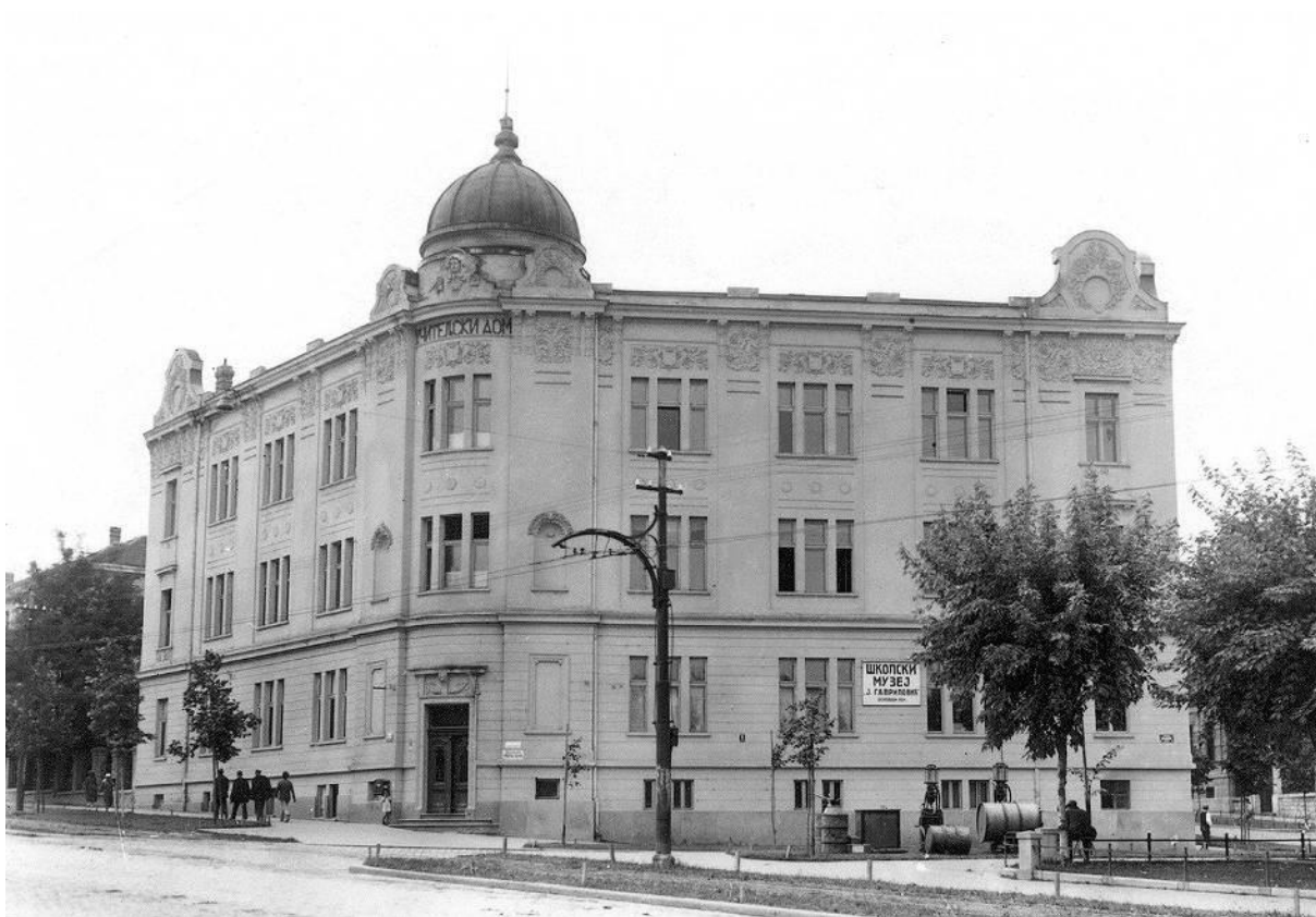
Слика 143 – Фасаде Учитељског дома (Колекција уметничког фотографа Милоша Јуришића)
