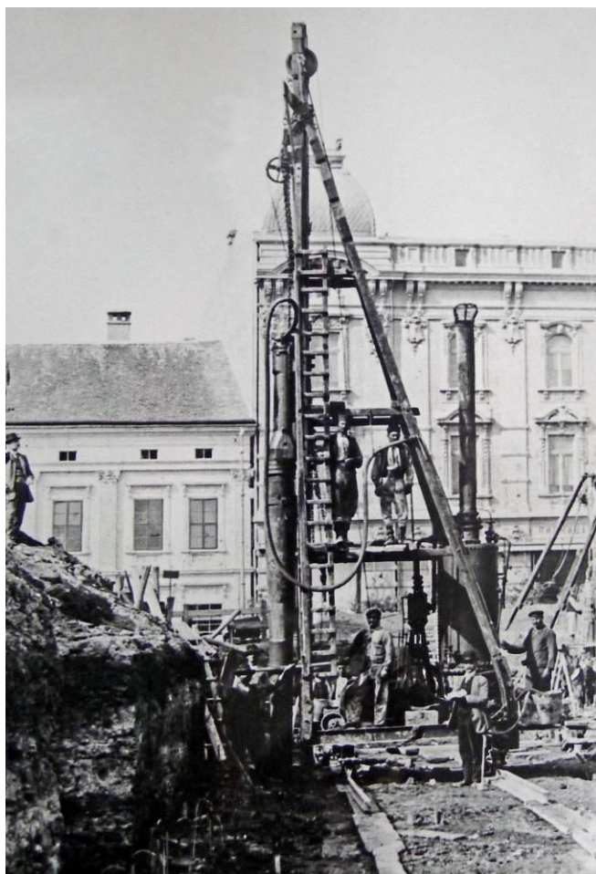
Слика 138 - Побијање шипова зграде хотела „Бристол“, у другом плану фасада зграде Београдске задруге (Архив Српске Академије наука и уметности 14410-I-V-1340)
