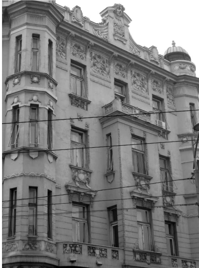
Слика 137 – Хотел „Бристол“, део фасаде ка Београдској задрузи (Фотографија аутора)
