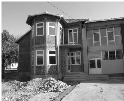
Slika 110: Izgradnja objekta mesne zajednice i mesne kancelarije u Toraku
