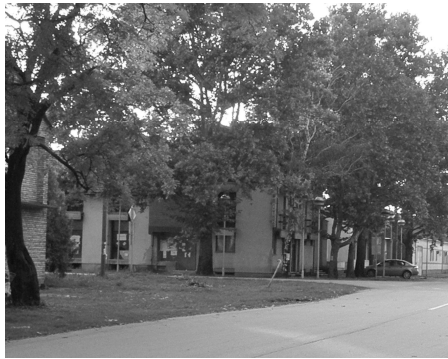
Slika 115: Napuštena zgrada hotela u centru Botoša
