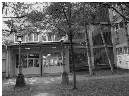
Slika 84: Novi objekat škole u Lazarevu
