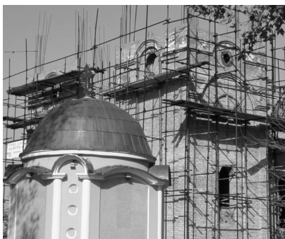
Slika 102: Pravoslavna crkva u izgradnji u Lazarevu
