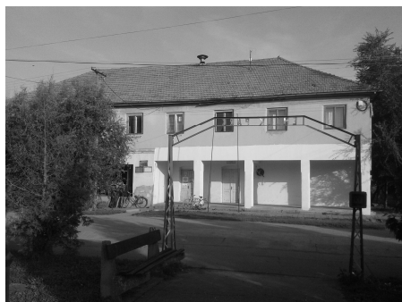
Slika 111: Obnovljen dom kulture u Tobić
