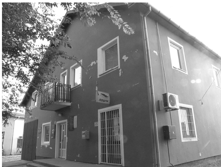
Slika 109: Zgrada mesne zajednice i mesne kancelarije u Banatskom Despotovcu
