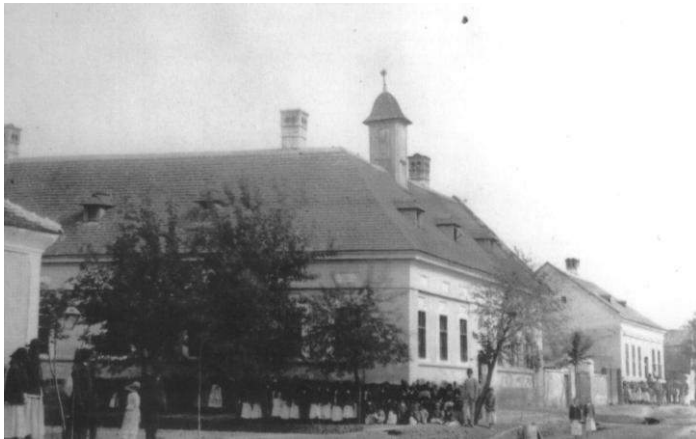
Slika 165: Zgrada škole u Karlovi 1889. godine
