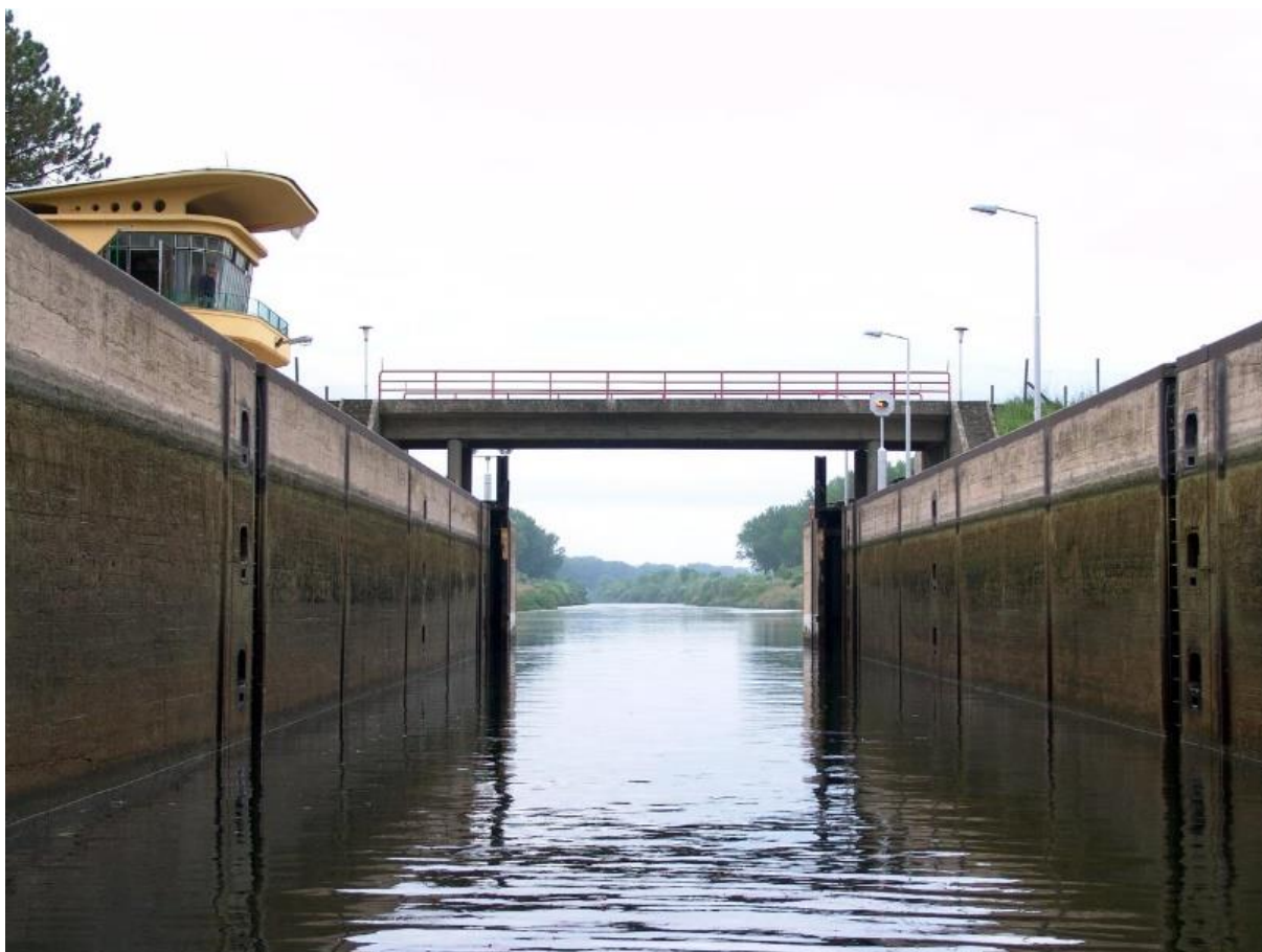
Sl. 3.11 Komora brodske prevodnice „Sombor“
