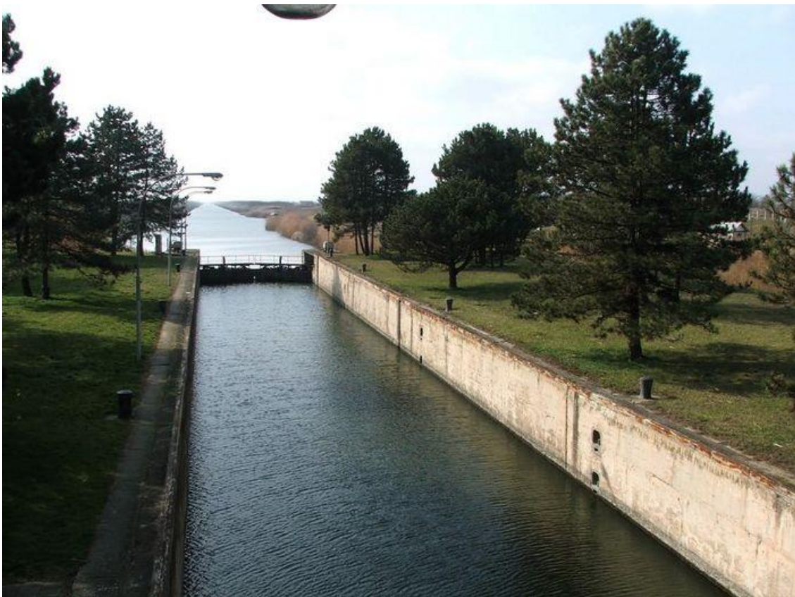
Sl. 3.8 Brodska prevodnica „Kucura“ – komora i pogled na gornju stranu kanala
