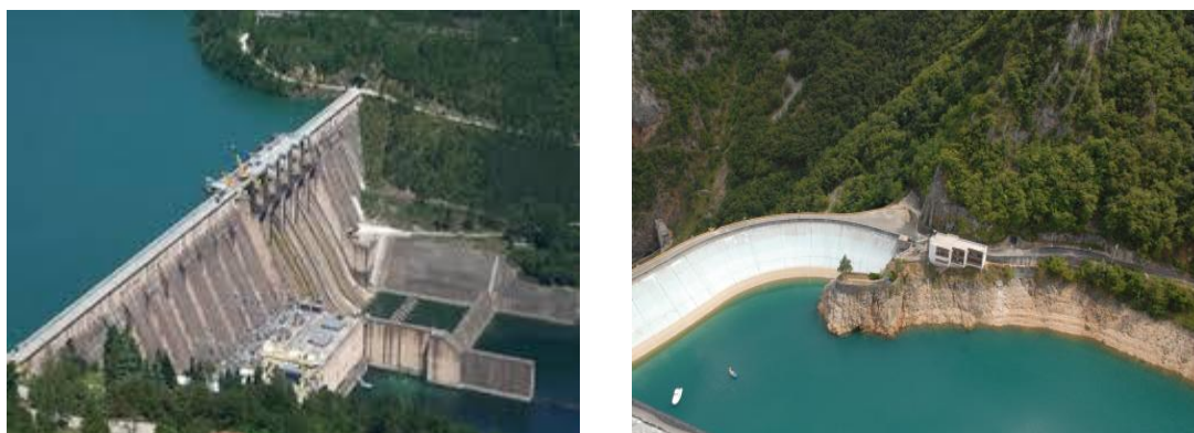
Slika 31. Brana Grančarevo, centralni objekat sistema HE na Trebišnjici
