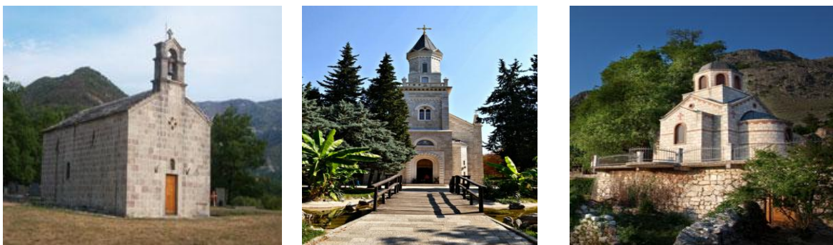
Slika 41. Crkva Sv. Arhandela, Saborna crkva Preobraženja Gospodnjeg, crkva Sv. Vasilija Tvrdoškog i Ostroškog
