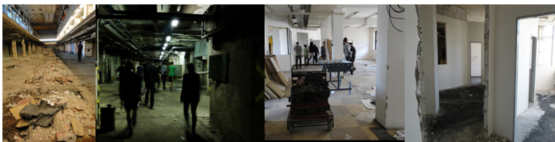
Slika 41: Devastirani prostori štamparijskog kompleksa - delovi hale, hodnika i objekta C - sukcesivno.
