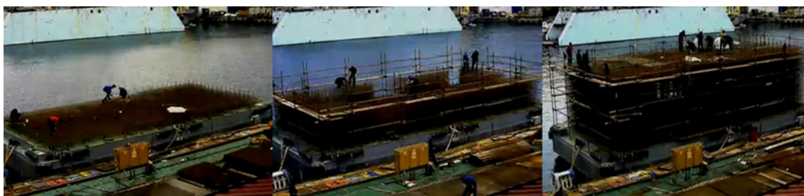
Slika 16: Kadrovi a1, a2 i a3 - Realizacija strukture - brodogradilište „Kraljevica“.
