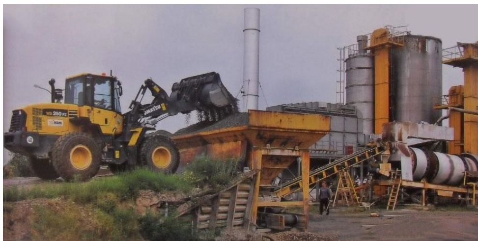
Слика 9.6.12 Изглед асфалтне базе капацитета 120 t/h
