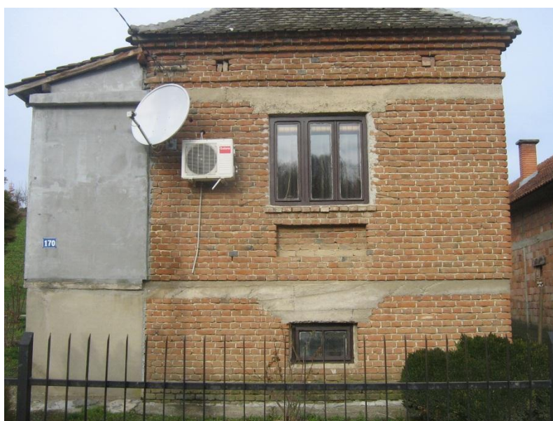
Slika 13. Kuća izgrađena šezdesetih (opcija 6, Begaljica)
