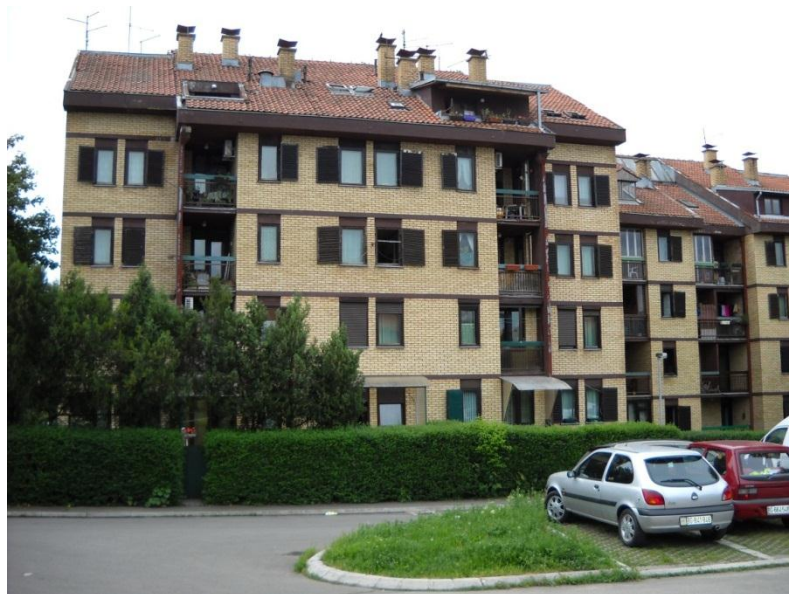
Slika 12. Zgrada s kraja osamdesetih (opcija 4 - naselje Avala grad, Resnik)
