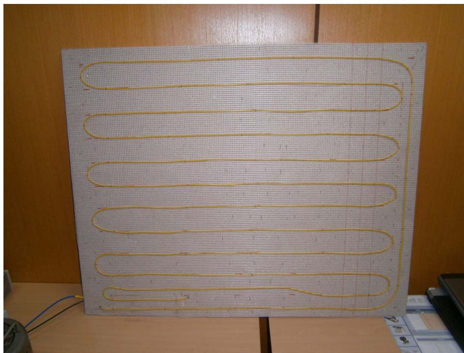
Слика 8.8 Детаљ монтаже грејног кабла
